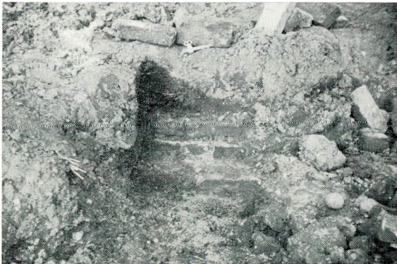
fig. 40. In 1959 opgegraven funderingen op de plaats a van fig. 39.
