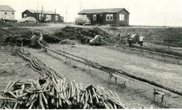
fig. 268. Machinaal wiepen spinnen voor de deltawerken te Bruinisse.
