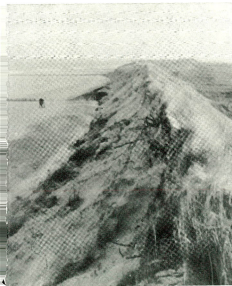
fig. 168. Weggeslagen duinvoet tussen de strandhoofden 3 en 4 aan het Noorderstrand van Schouwen bij de storm van 30 dec. 1904.
