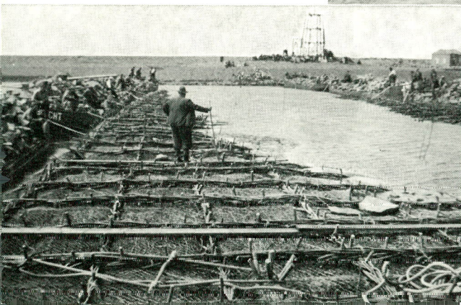
fig. 177. Het zinkstuk met roosterwerk van metaalgaas bijna gereed voor zinking.
