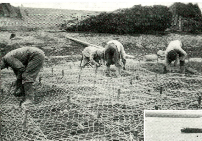
L. G. Pikkaart, Bruinisse. fig. 175. Samenstellen van een zinkstuk met rijshout en metaalgaas.
