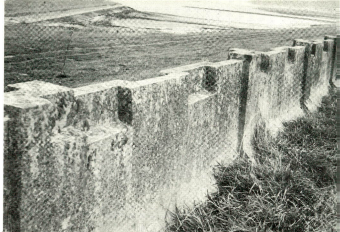
fig. 133. Betonmuur „de Muralt” met vertanding te Stavenisse.
