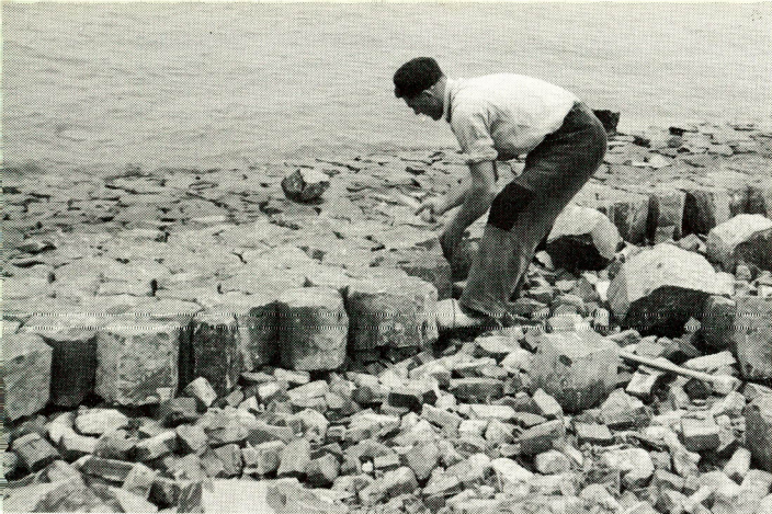
fig. 184. Het zetten van een basaltglooiing langs het Zijpe te Bruinisse.
