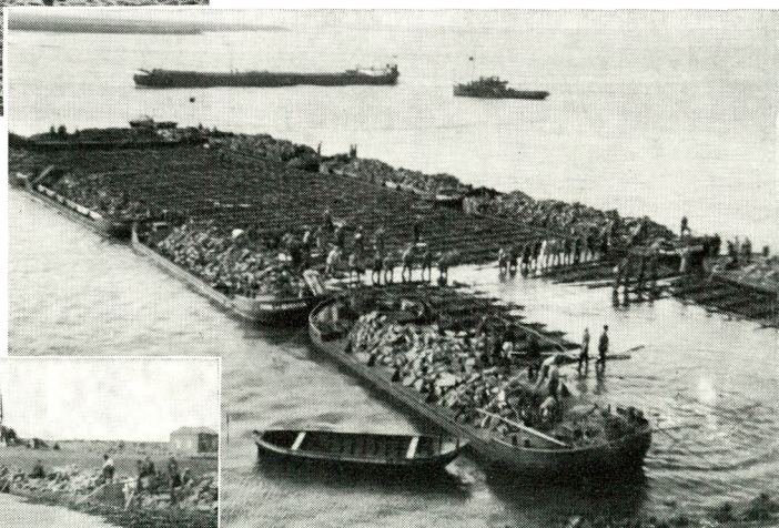
fig. 176. Begin van ballasten van het zinkstuk uit fig. 175.
