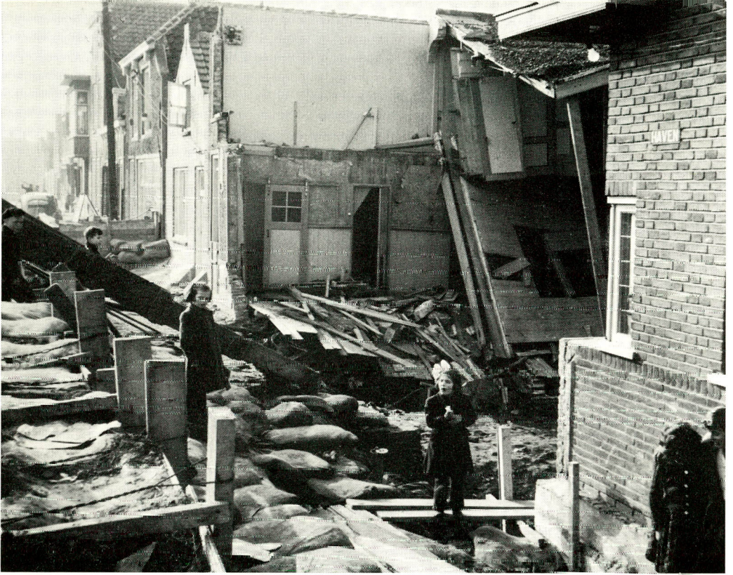
fig. 107. Doorbraak van de coupure in de Kaaistraat te St. Maartensdijk.
