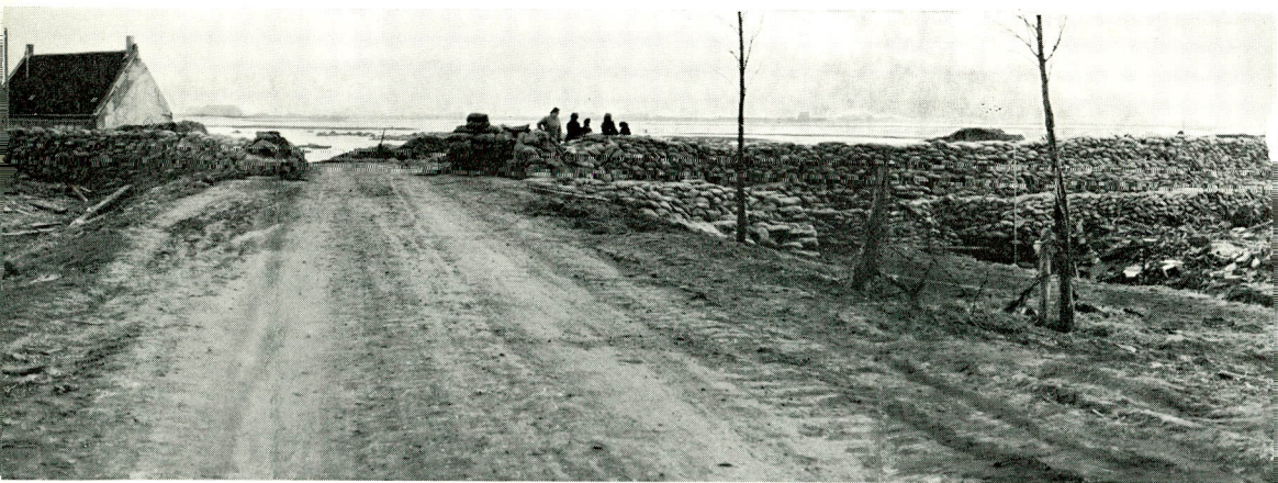
fig. 108. Dijkbressen in de Vierde dijk te St. Maartensdijk met zakken klei gedicht.
