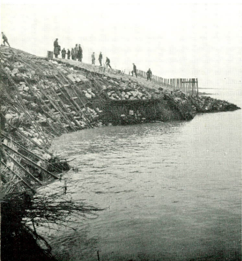
fig. 81. Herstel van de dijkval van 1955 te Scharendijke, gezien uit het oosten.
