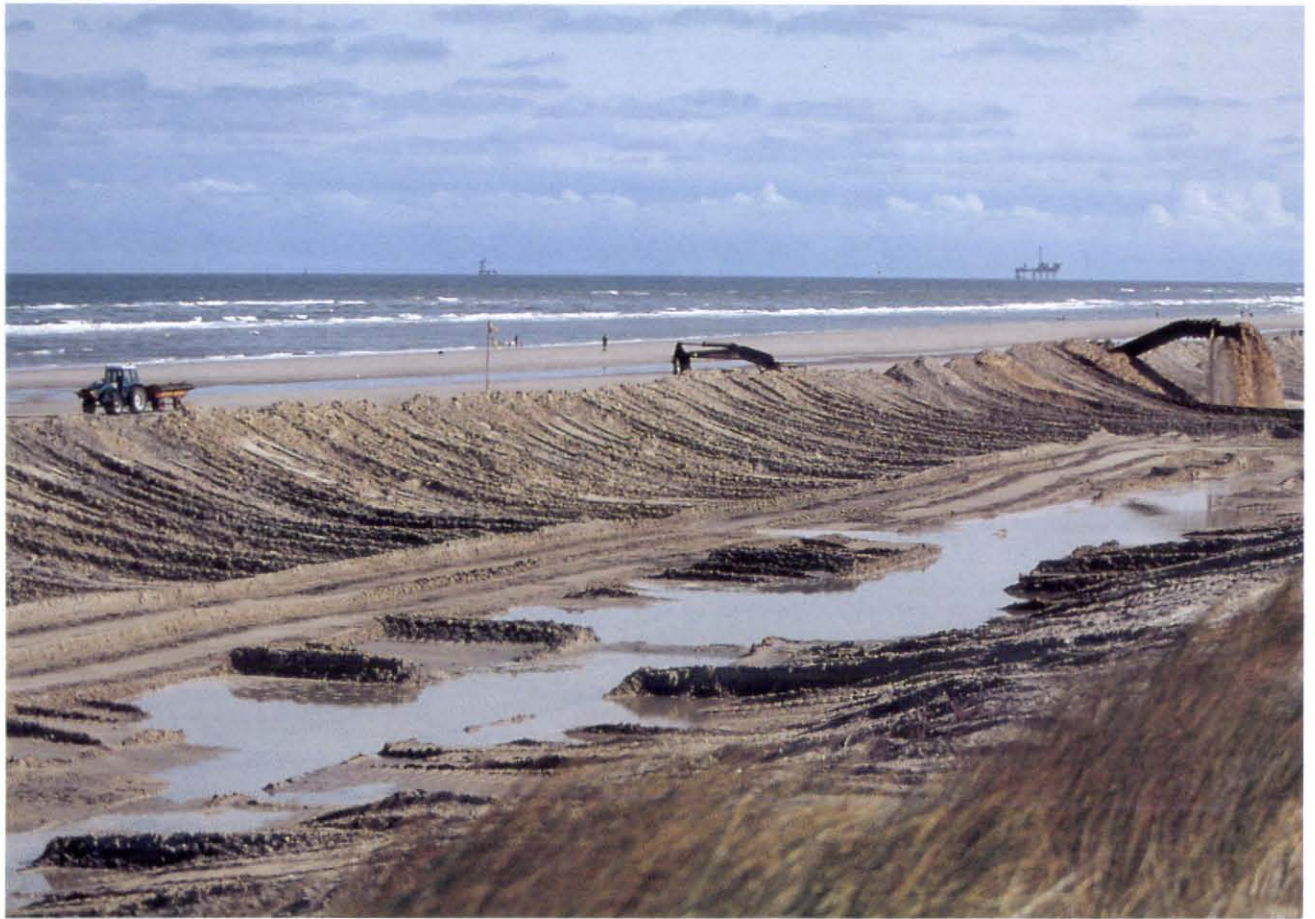
Foto 34 Strandsuppleties als wapen tegen de oprukkende zee.
