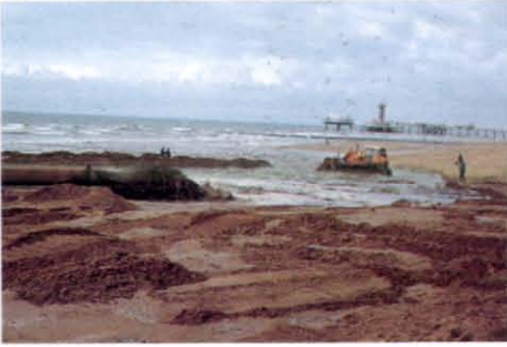
Foto 24 Het weggespoelde zand wordt weer op zijn plaats gelegd.
