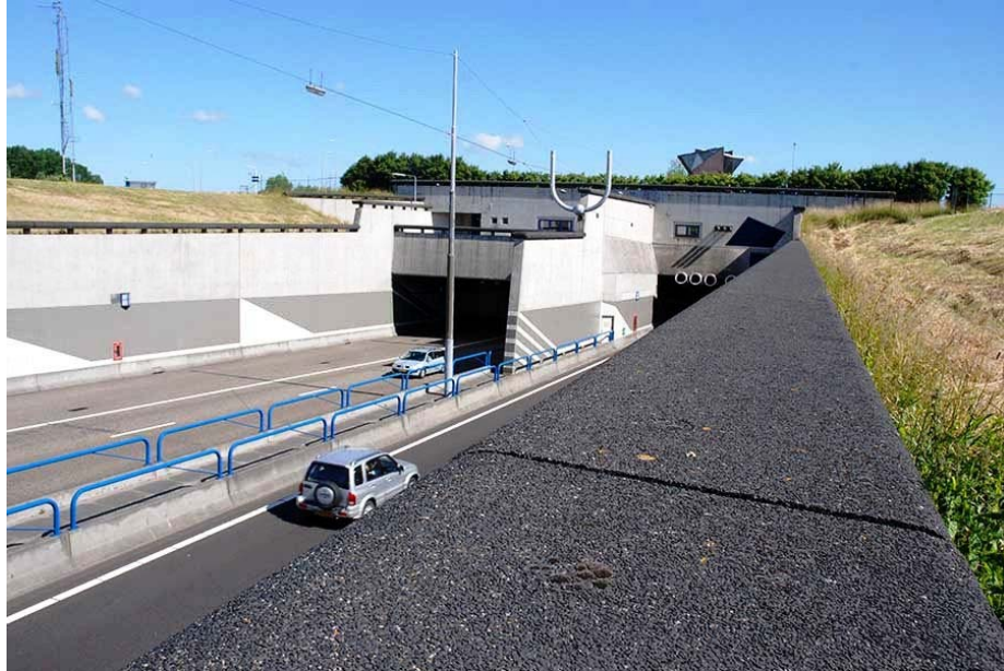
Figuur 1: Wegsituatie tunneluitgang [foto: Michel Rikkelman]
