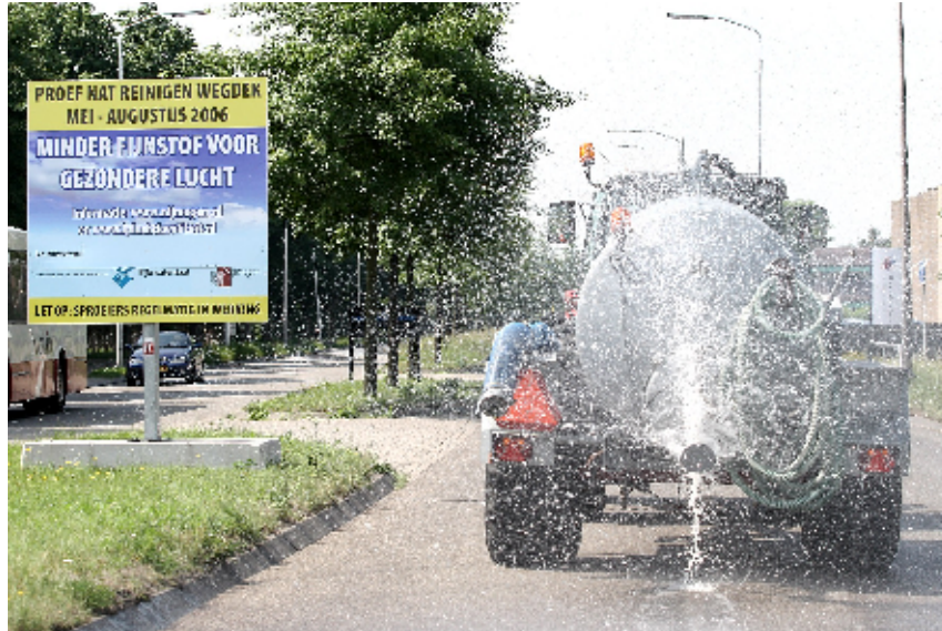
Figuur 1: besproeien van de Energieweg met een waterton
