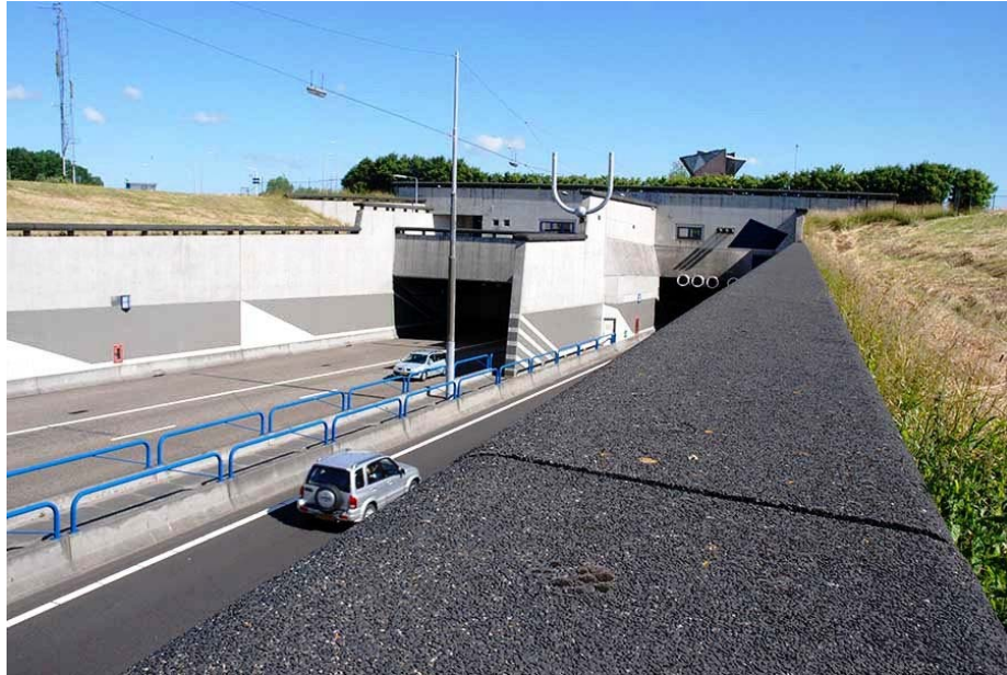
Figuur 1: Wegsituatie tunneluitgang [foto: Michel Rikkelman]
