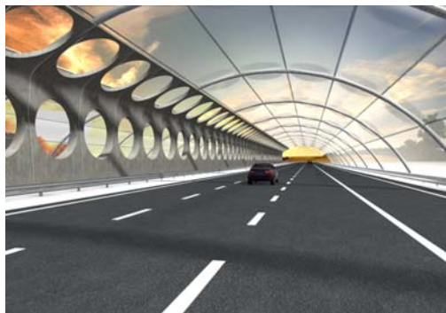
figuur: DHV/NIO: opgeblazen kussens van ethyleentetrafluorethyleen; ETFE
