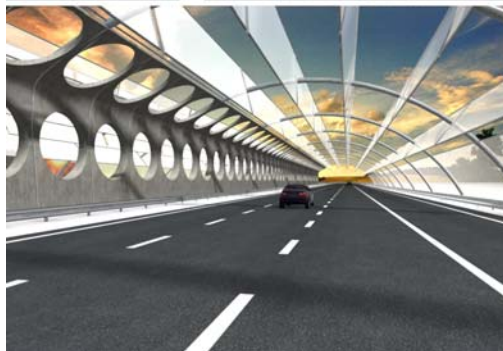
figuur: DHV/NIO: lamellen van polymethylmetacrylaat; PMMA
