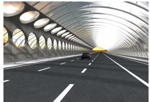
figuur: DHV/NIO: opgeblazen kussens van ethyleentetrafluorethyleen; ETFE
