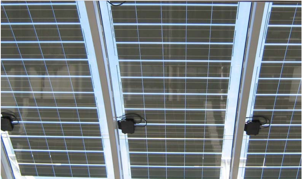
Figuur 9 Koudgebogen gelaagd glas met zonnecellen
