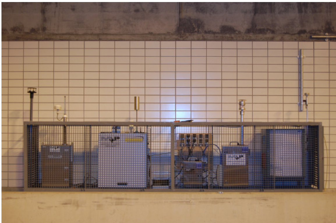
Figuur 13: Foto van de meetopstelling op meetpunt 1 aan het begin van de proef. Van links naar rechts: GRIMM, Airpointer, LVS, CPC (BAM/TU Delft)
