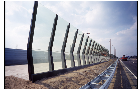
afbeelding 9 Voorbeeld PMMA in geluidsscherm
