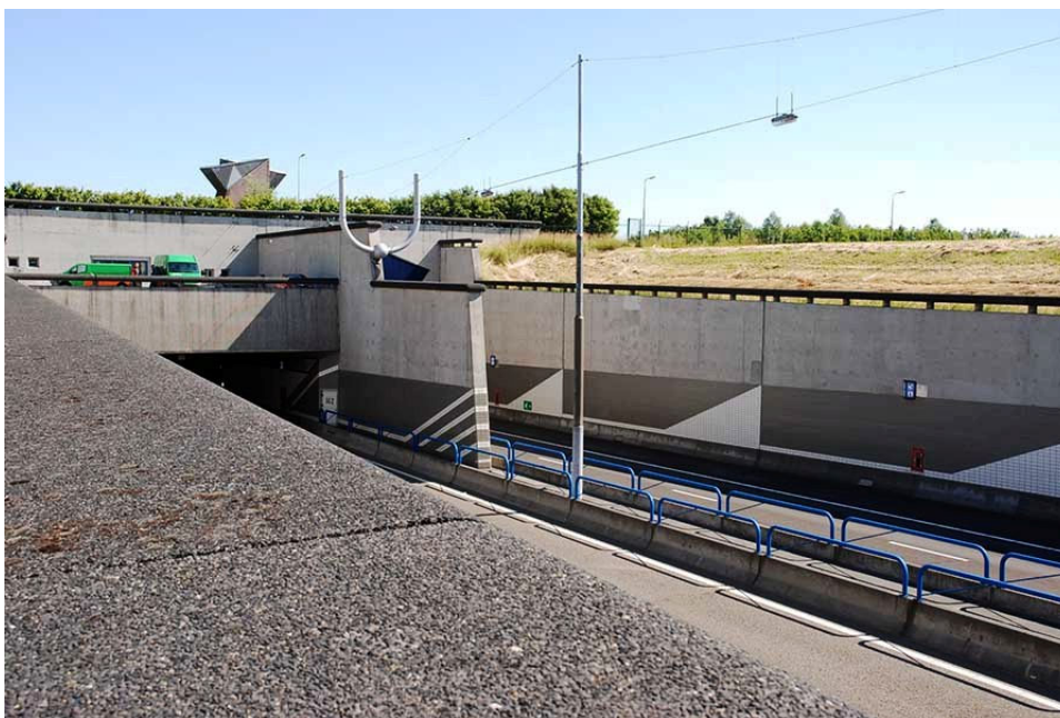
figuur 1 Zuidelijke tunnelmond Wijkertunnel Rijksweg A9 [foto: Michel Rikkelman]
