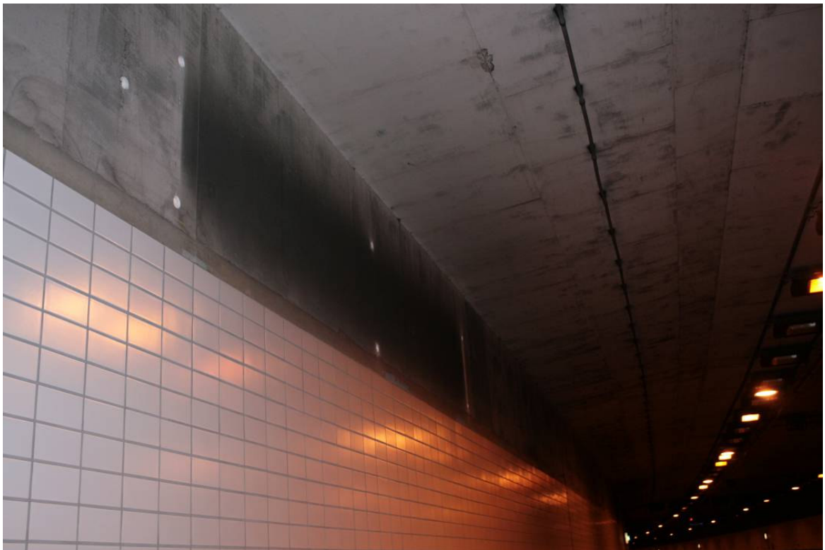
Figuur 4: Extra depositie op de tunnelwand waar een actief rek gemonteerd was
