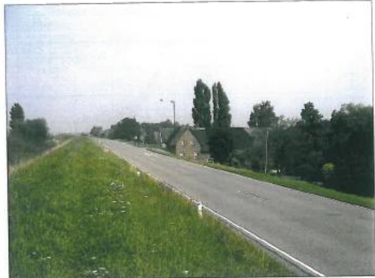
↑ Figuur 1 Lekdijk Alblasserwaard; van deze dijk is een probabilistische beschouwing gemaakt. Water in de rivier stroomt tijdens een maatgevende hoogwaterstand door het watervoerende pakket onder de dijk door en dringt ter plaatse van het achterland het slecht doorlatende pakket in. De mate van indringing wordt bepaald door de tijdsduur van de hoogwatergolf en de opbouw en eigenschappen van de slecht doorlatende grond in het achterland.
