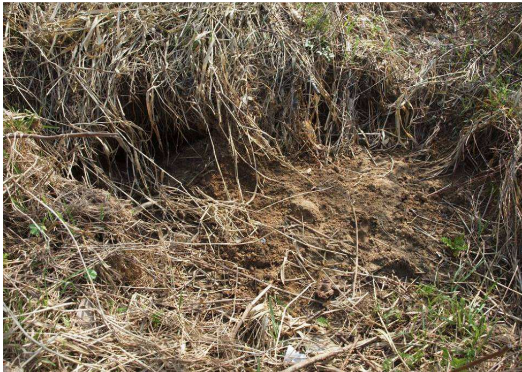
Foto 2. Recente graafsporen aan ventilatiegaten.
