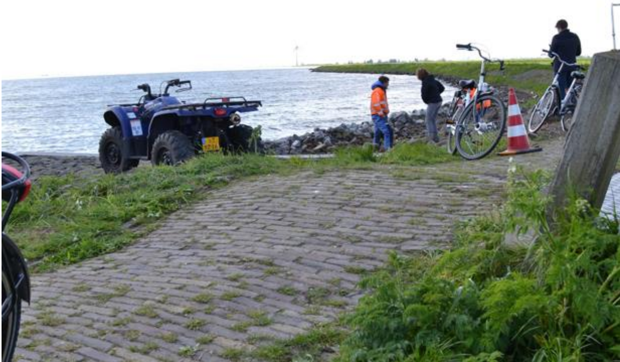
Figuur S.3 Zettingen leiden tot een onregelmatige en minder stabiele kade met weinig comfort voor fietser en wandelaars
