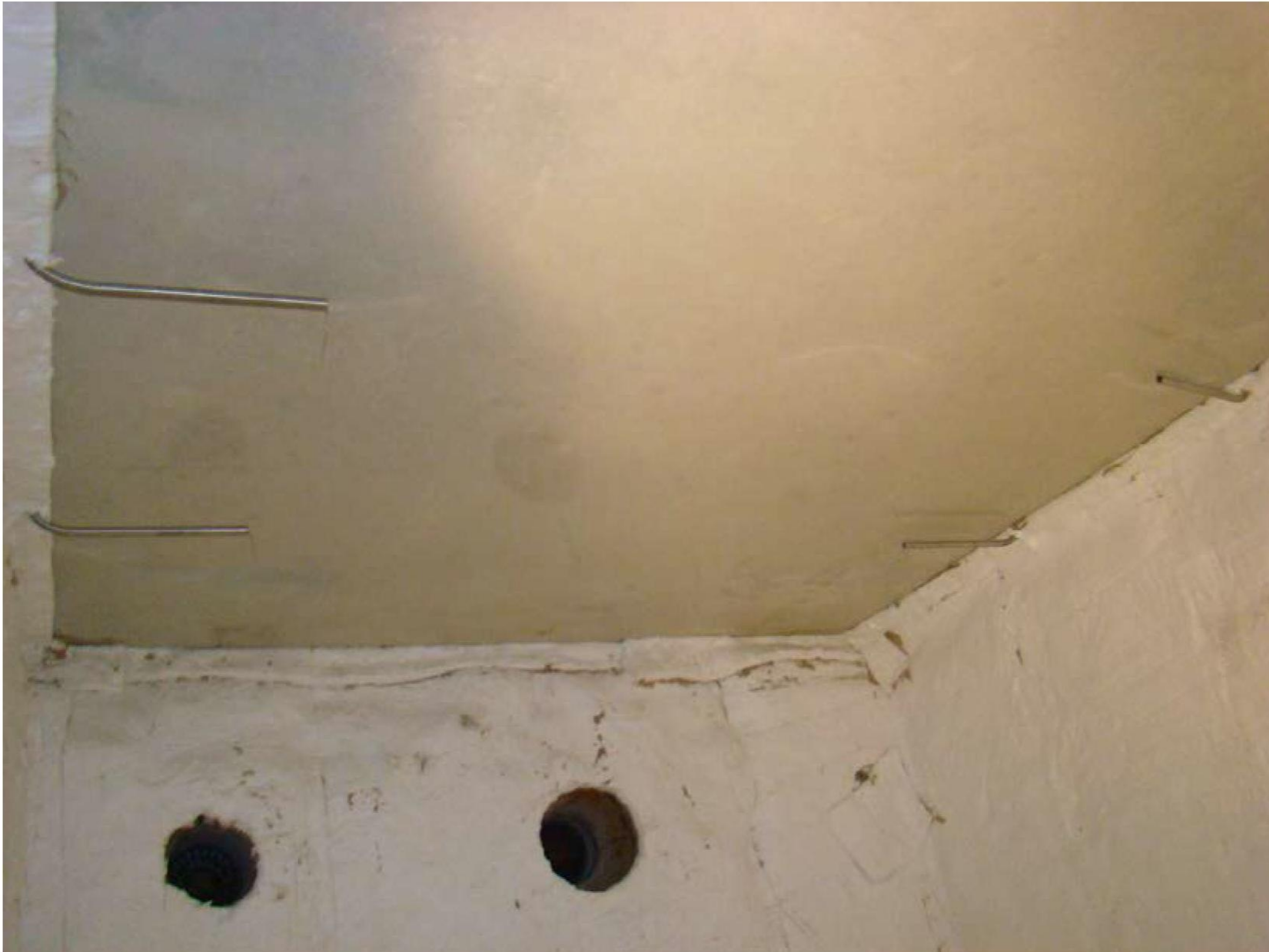
Foto 1: Verhit oppervlak voor de brandproef
