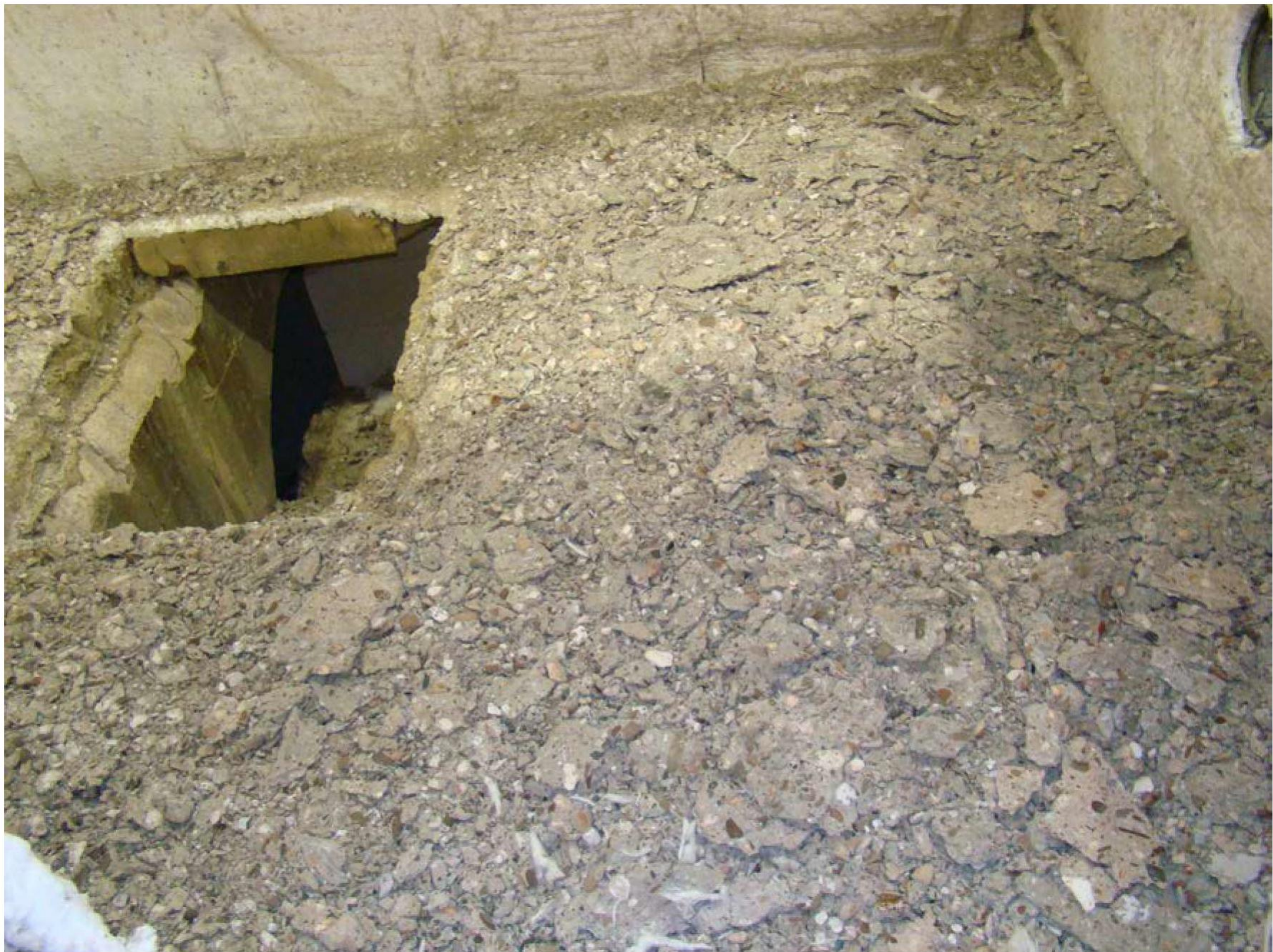
Foto 7: Gespat beton in de brandwerendheidsoven
