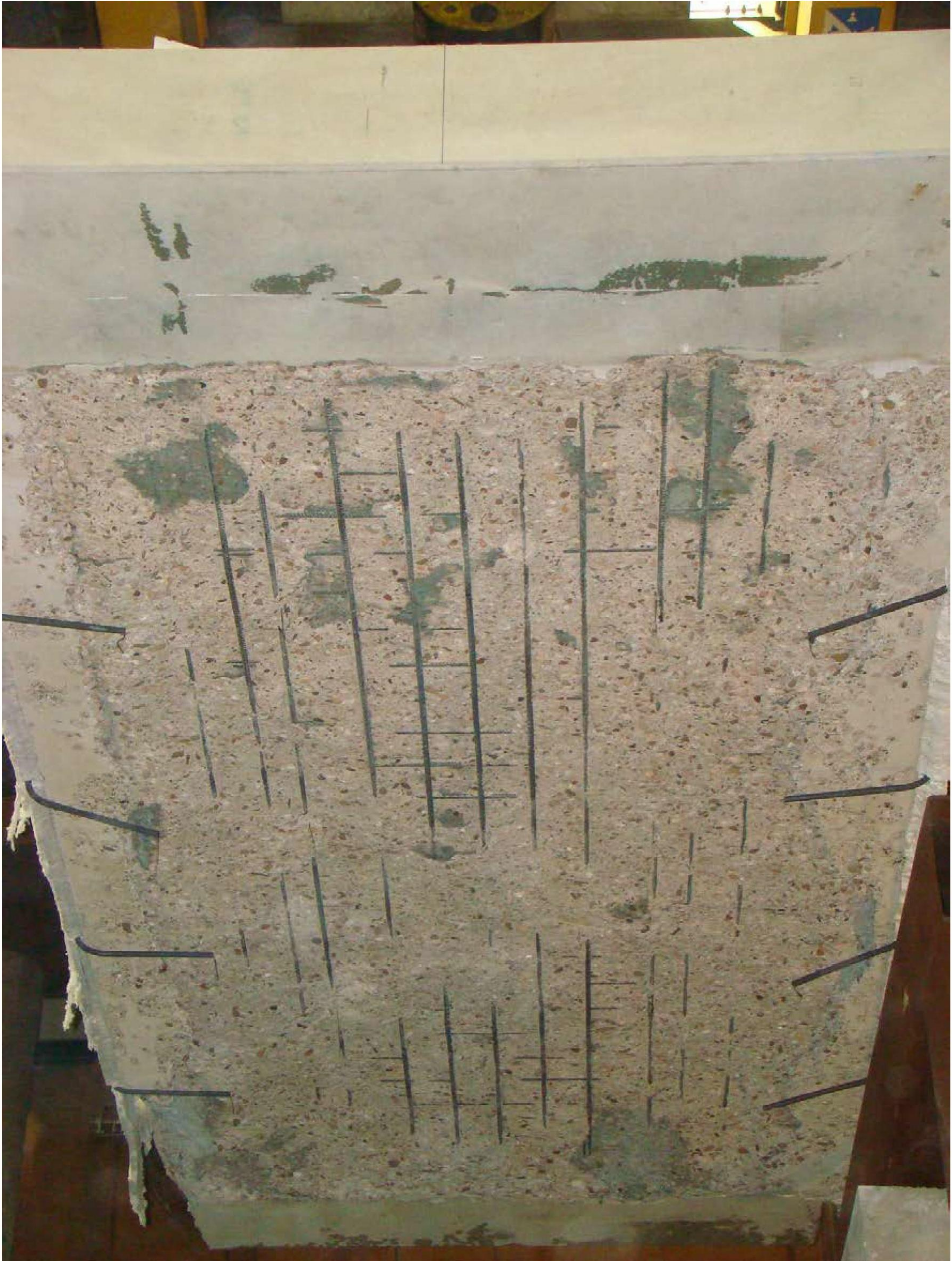
Foto 3: Verhit oppervlak na de brandproef
