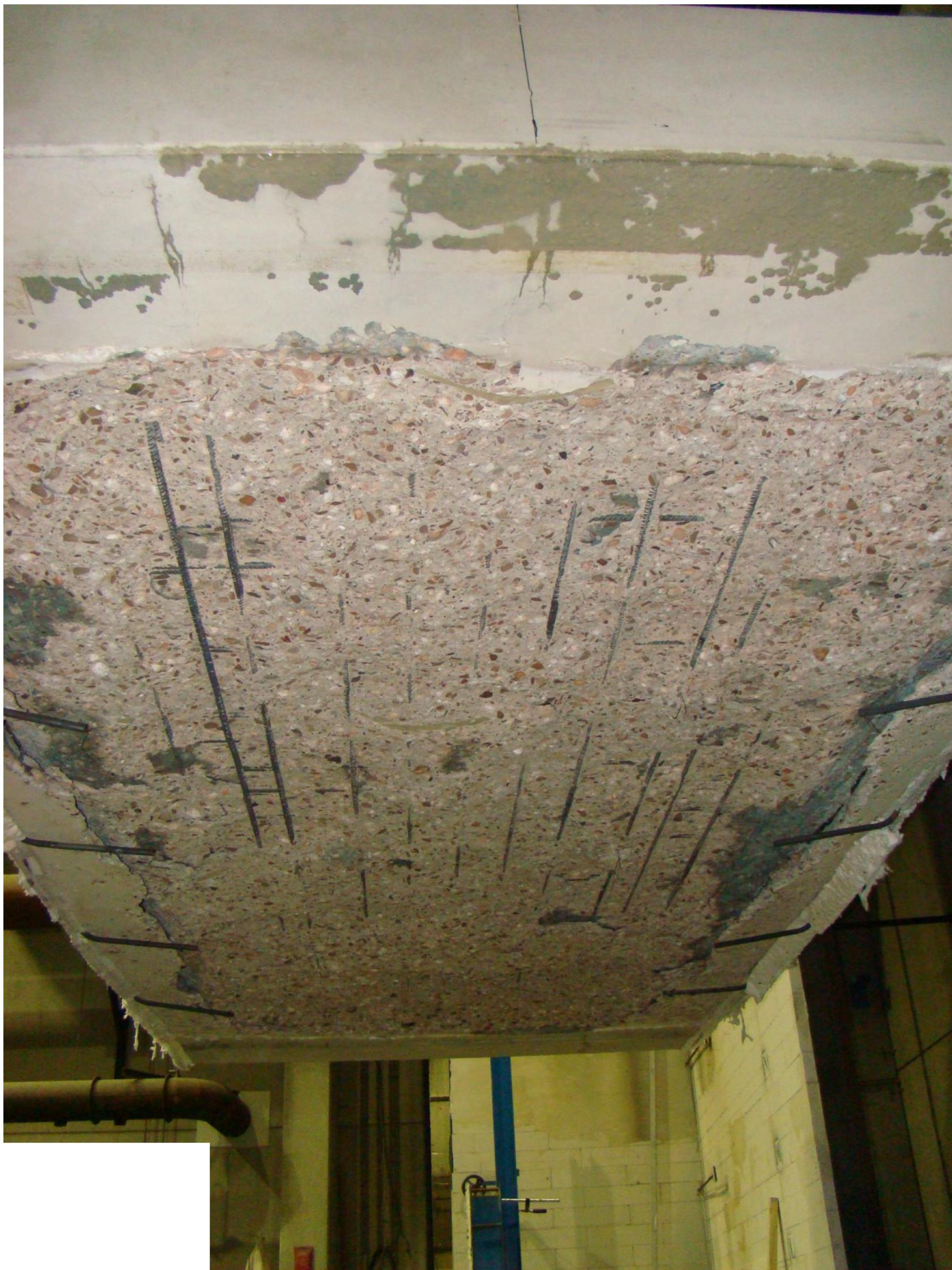
Foto 3: Verhit oppervlak na de brandproef
