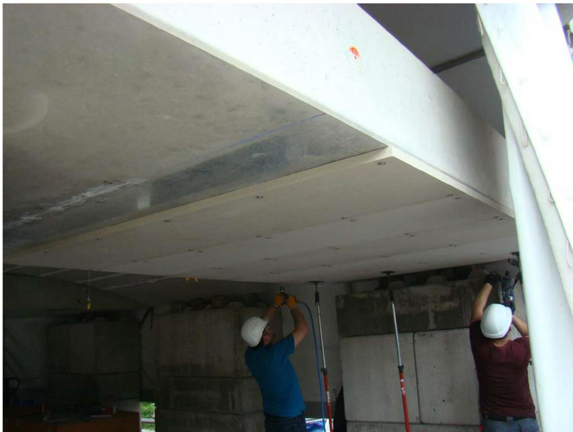
Foto 1: Aanbrengen van de brandwerende bekleding
