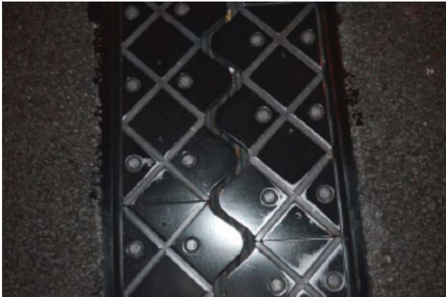
Figuur 10: Profiel bestaande voeg (profiel type o.1)
