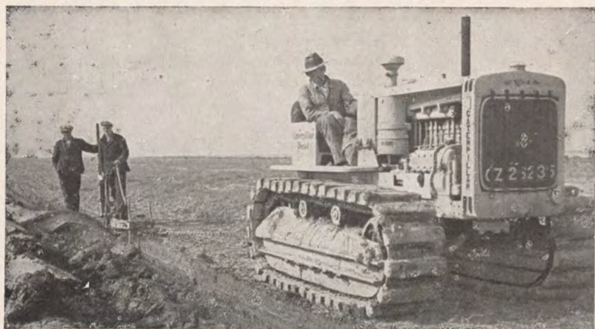
Het bovenbrengen van een kleilaag door middel van diepploegen. (Juni 1937).
