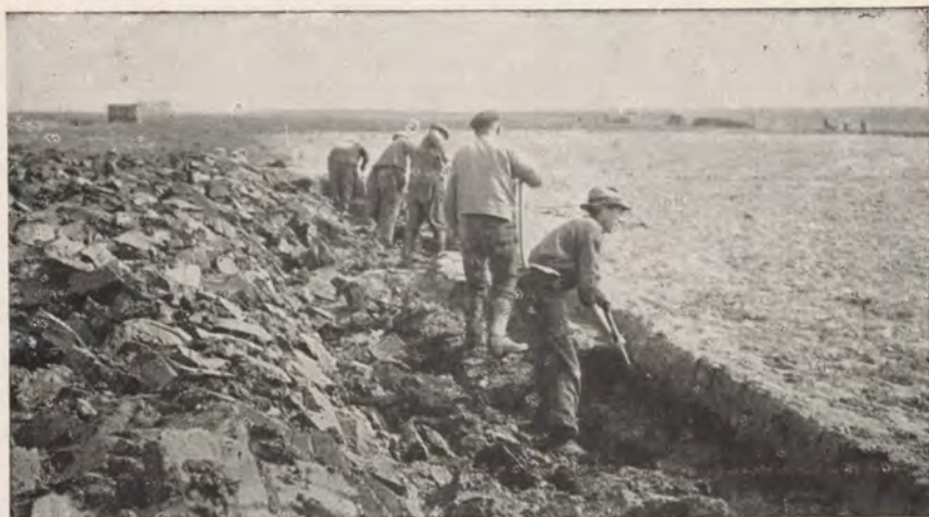
Diepspitten in werkverschaffing. Bovenbrengen van een kleilaag. (Juni 1937).
