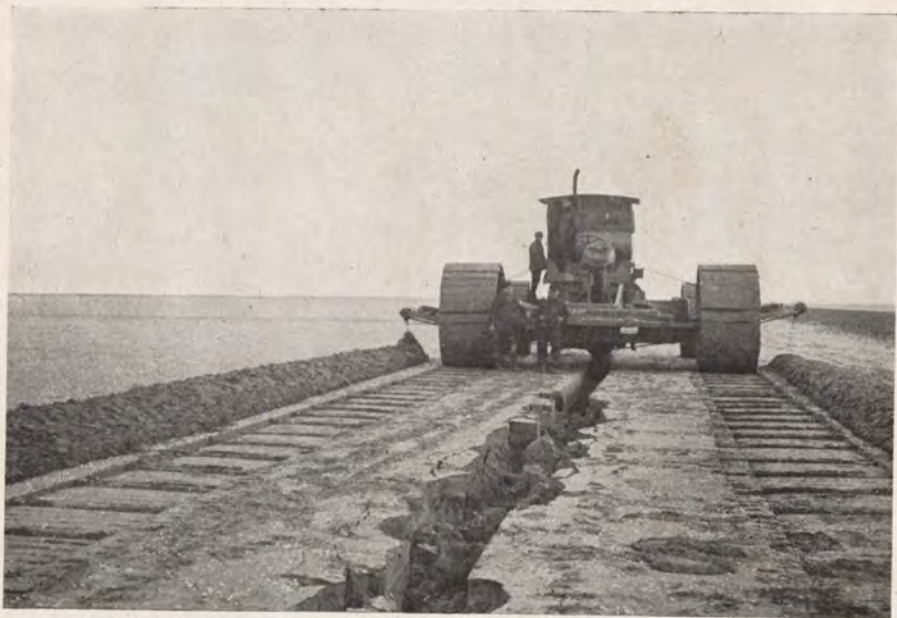
Stuifvrij maken van zandgronden door de woelkleimachine. (Najaar 1930). Foto Niestadt.
