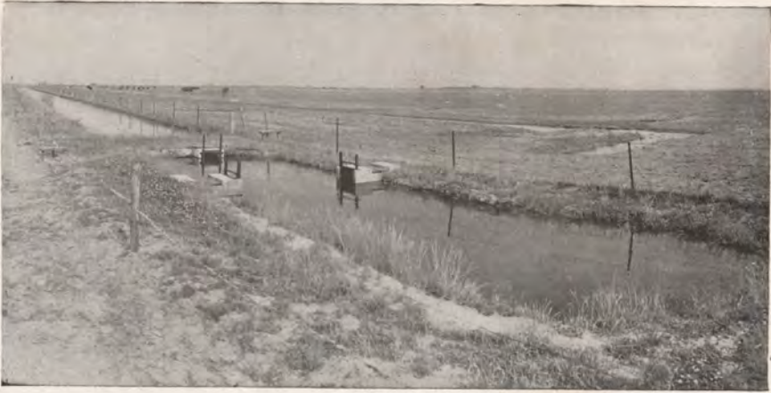
Infiltratiewerken voor watervoorziening van grasland. (April 1934).
