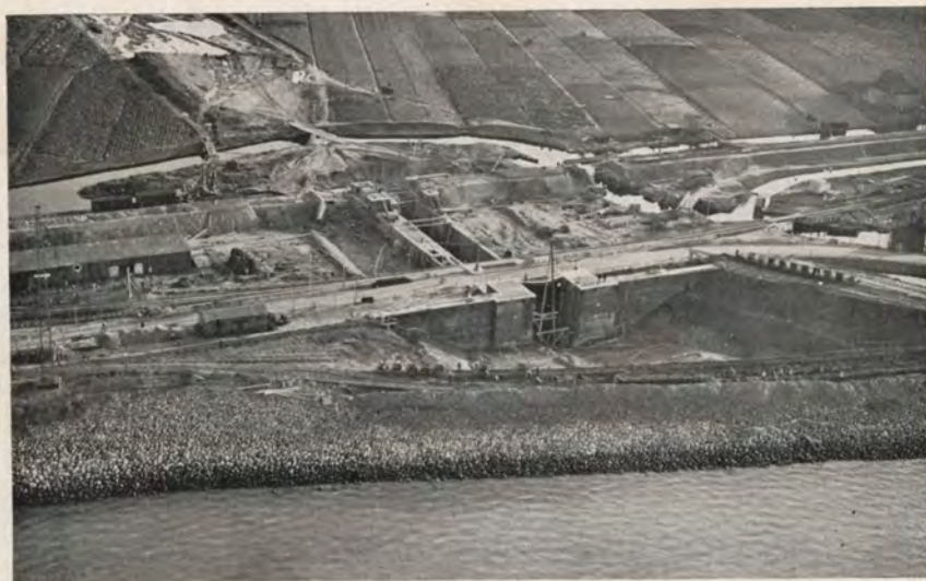
Overlekersluis ten Westen van Medemblik in aanbouw. Op den voorgrond de nog niet drooggevalen Wieringermeer. (Nov. 1929). Foto M. L. D.
