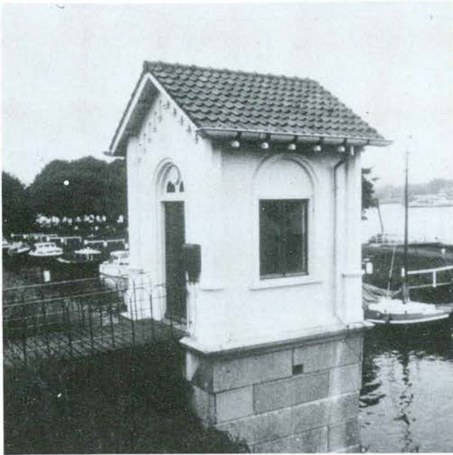
Het 19e eeuwse peilmeetstation Schoonhoven, per 1 januari 1985 vervangen door een nabijgelegen nieuw station.
