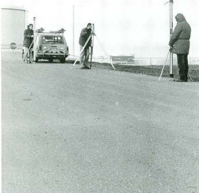
De Meetkundige Dienst van de Rijkswaterstaat aan het werk: Optisch waterpassen in 1985.
