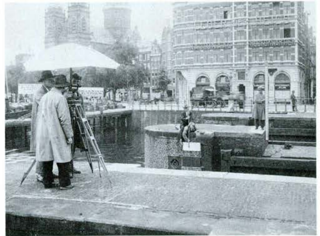
Het instrument van Hildebrand en het met behulp daarvan maken van de aansluiting aan het NAP te Amsterdam.
