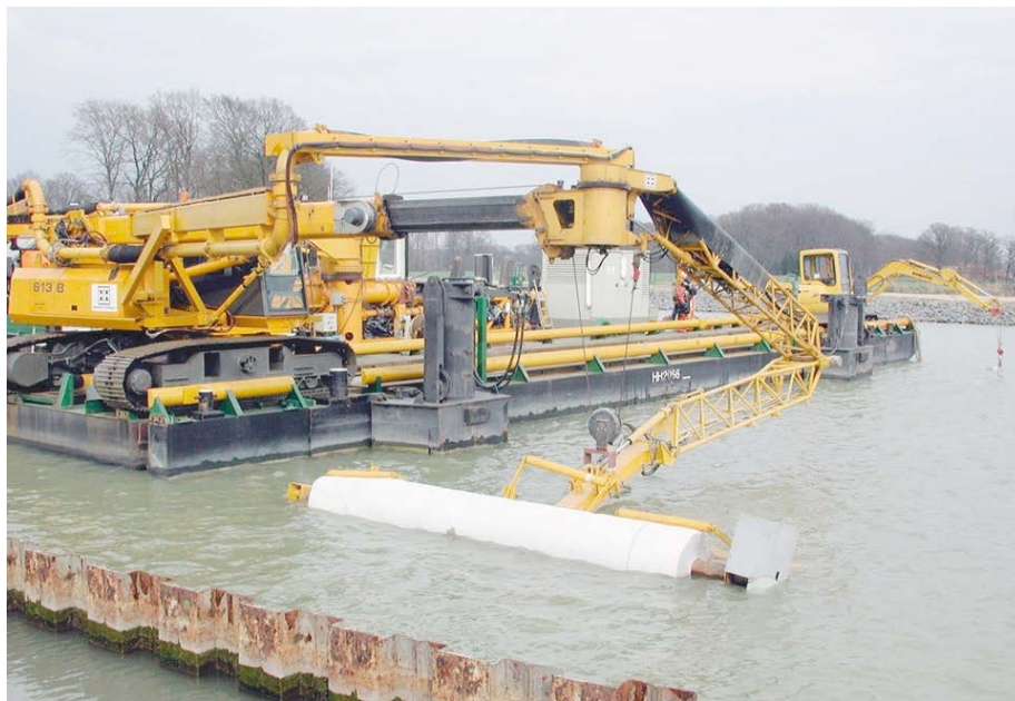
Figuur 3.10 Een voorbeeld van aanbrengen van bentonietmatten (bron: prosegeotechniek.nl )
