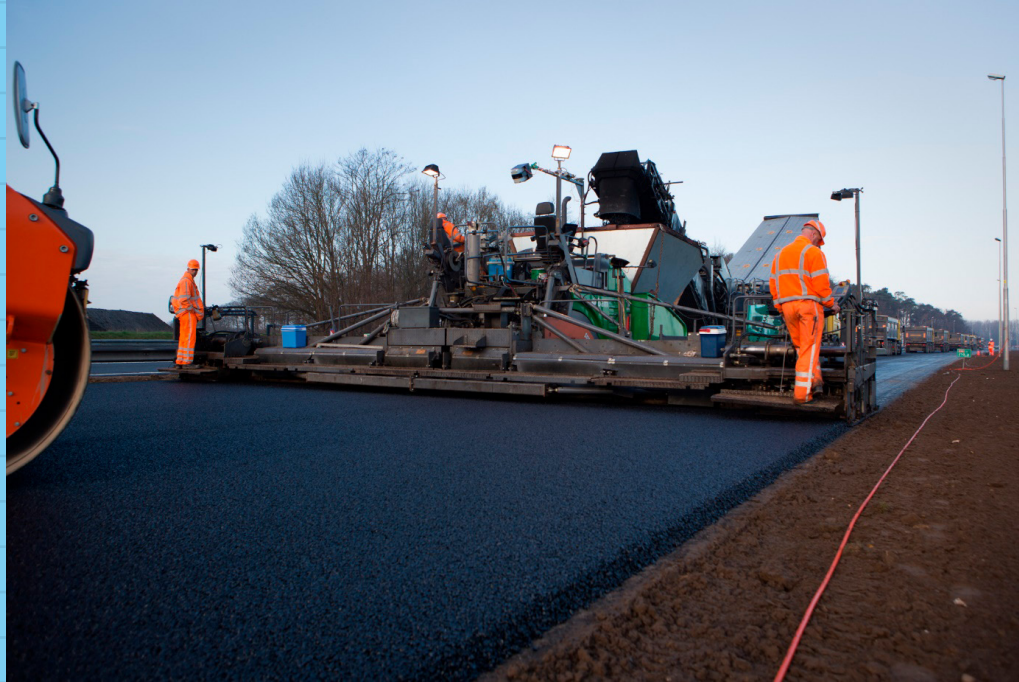
Onderhoud in uitvoering op onze Rijkswegen. Foto Marcel Vogel
