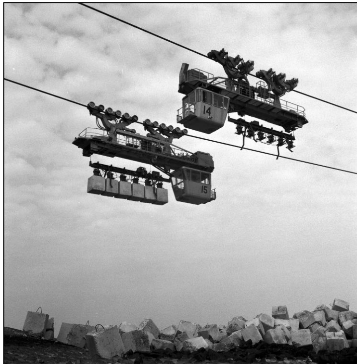
Figuur 3.11: Afsluiting van het Brouwershavensche Gat door het storten van betonblokken (https://beeldbank.rws.nl, Rijkswaterstaat / Afdeling Multimedia Rijkswaterstaat
