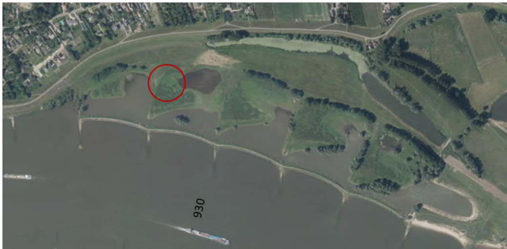
Figuur 2: De aangelegde situatie binnen de Heesselsche Uiterwaarden zoals blijkt uit een luchtfoto daterend van 15 september 2020 (bron: Streetsmart, Cyclomedia).
