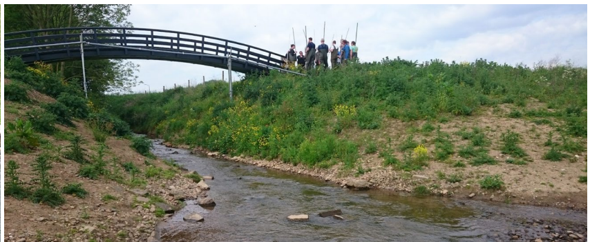
Monding Sint Jansbeek bij Boxmeer: de stuw en drempel vormen een harde barrière voor vissen (l). Die constructies zijn verwijderd en op de plek van de stuw is een nieuw houten voetgangersbruggetje gebouwd; de beek is sindsdien weer vrij optrekbaar voor vis (r).
