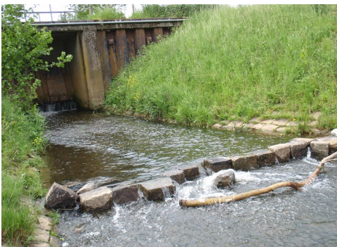
Monding Sint Jansbeek bij Boxmeer: de stuw en drempel vormen een harde barrière voor vissen (l). Die constructies zijn verwijderd en op de plek van de stuw is een nieuw houten voetgangersbruggetje gebouwd; de beek is sindsdien weer vrij optrekbaar voor vis (r).
