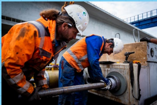
Ontspannen van de voorspankabels
