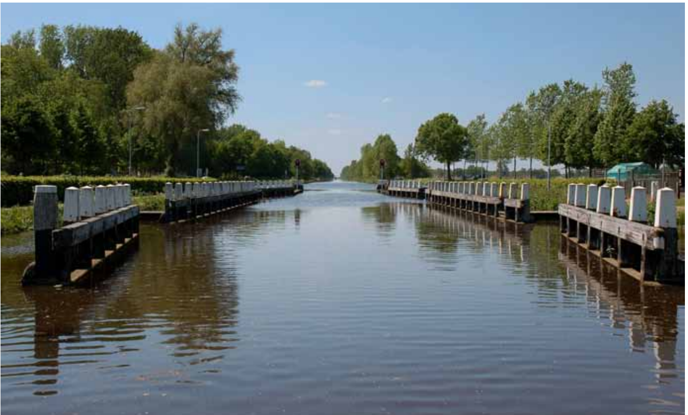
De sluisolk bestaat uit een groene kolk bekleed met intussen overgroeide basaltzuilen en is voorzien van vrijstaande remmingwerken.
