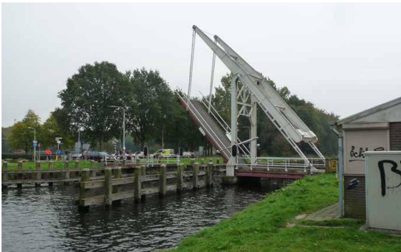
De ophaalbrug in de Heikantsbaan in Tilburg is een van de originele bruggen die door Rijkswaterstaat is aangeduid als een object met een bijzondere cultuurhistorische waarde.
