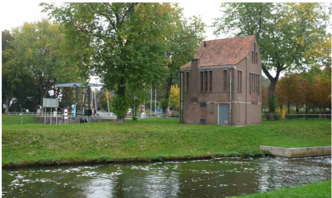
Het terrein van sluis IV met op de voorgrond de spuleiding en het schakelhuis-pompstation, op de achtergrond de sluiswachterswoningen en de ophaalbrug over de sluisolk.
