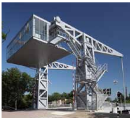
Brug over de Piushaven in Tilburg.
