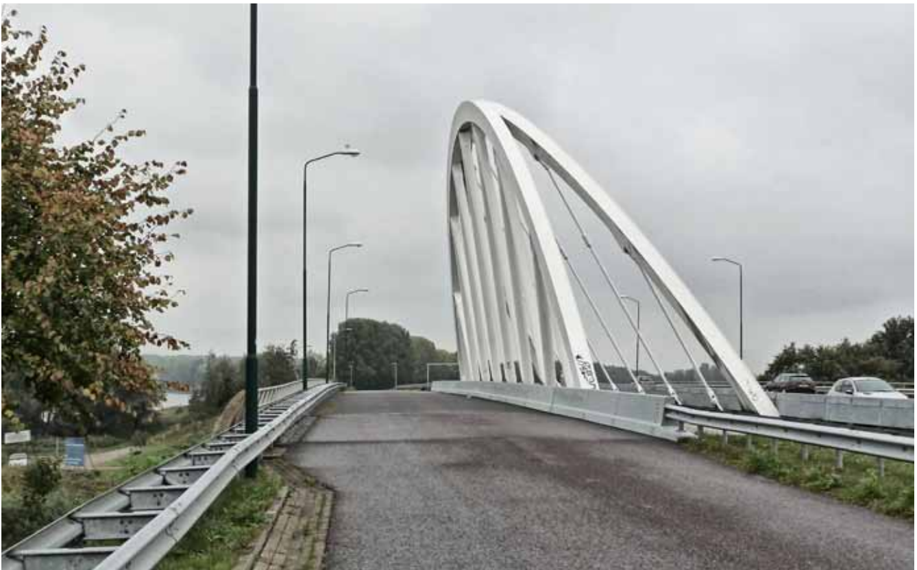
De Terheijdensebrug over het Markkanaal betreft een boogbrug.
