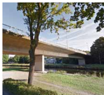
Kokerbrug: brug Quirijnstoklaan in Tilburg.
