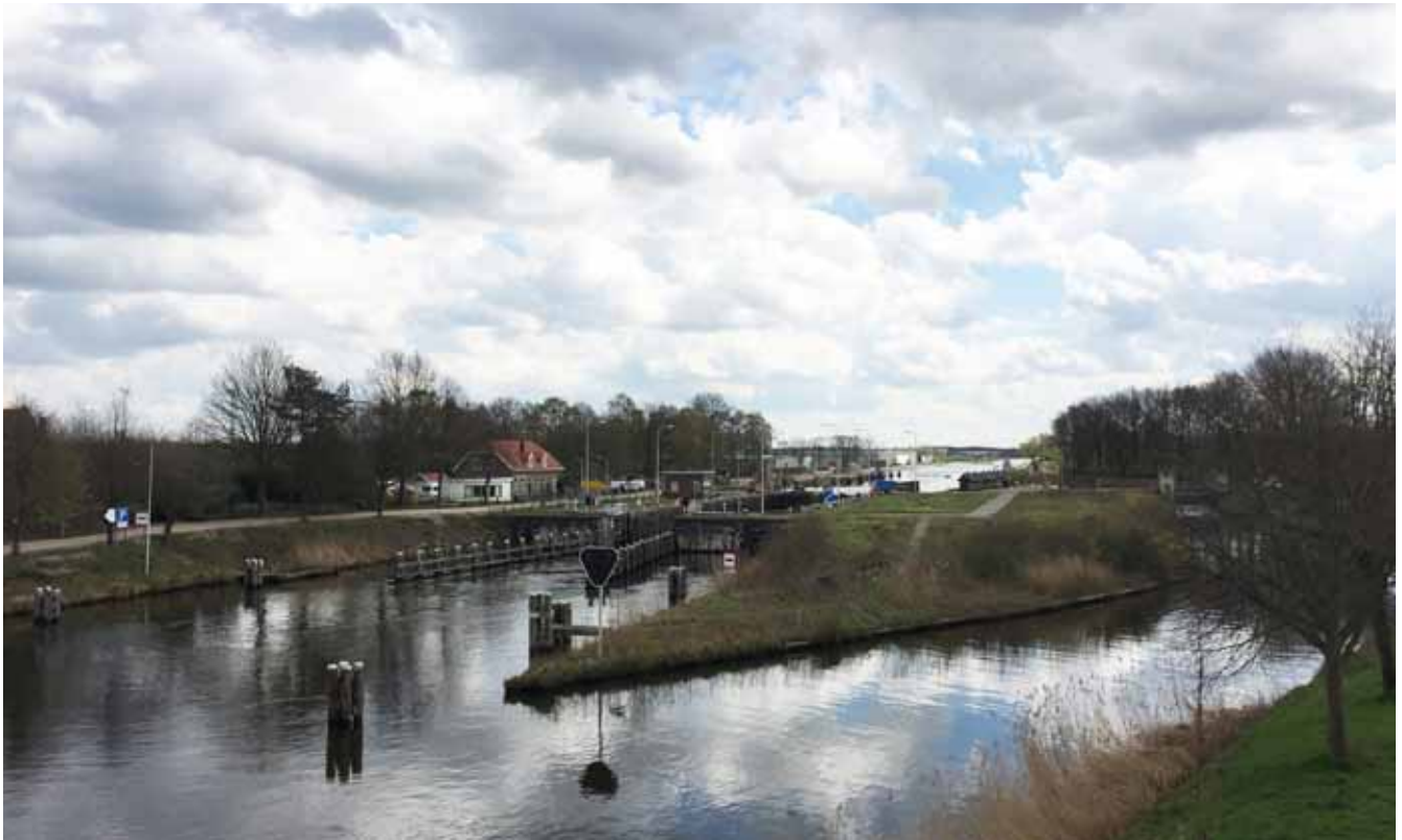
Sluis II in Tilburg betreft een enkele bajonetsluis en kent een nog grotendeels authentieke inrichting met het originele bedieningsgebouw, schakelhuis-pompstation, sluiswachterswoningen en de spuleiding met spui en brug. Op de eerder geplande sloop van de sluis is geanticipeerd door de beplanting op het middeiland te rooien.
