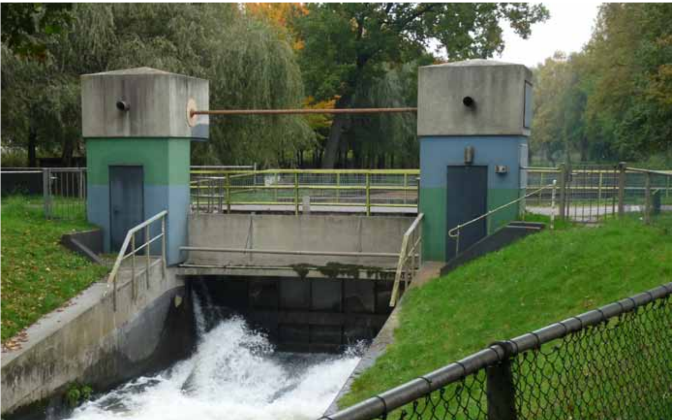
Om piekafvoeren in de Dommel via het Wilhelminakanaal te kunnen afvoeren zijn in de jaren '30 spuilleidingen bij sluis I t/m IV aangelegd. Op de foto staat het spui van sluis IV.
