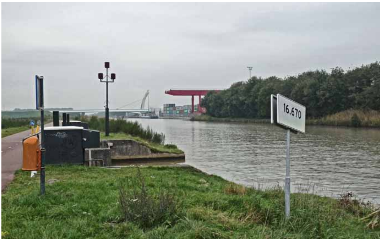
In de jaren '70 werd het Wilhelminakanaal verbreed tussen Oosterhout en sluis II ter verbetering van de afvoer van pieken in de Donge en de Dommel. Op de foto het verbrede Wilhelminakanaal met het spui van de Donge ter hoogte van industrieterrein Vossenbergh in Tilburg.
