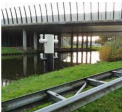
Plaatbrug: brug Koppenberg (A50) bij Son.
