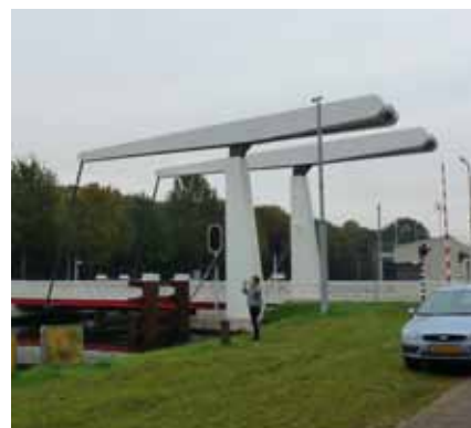
Brug in de Dr. Deelenlaan in Tilburg.
