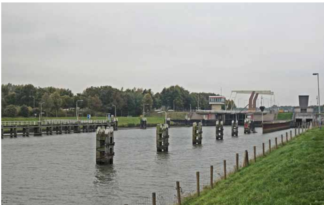
De Marksluis in Oosterhout met de originele wit-rode kleurstelling van het bedieningsgebouw, dat alleen nog functioneert als noodbediening.
