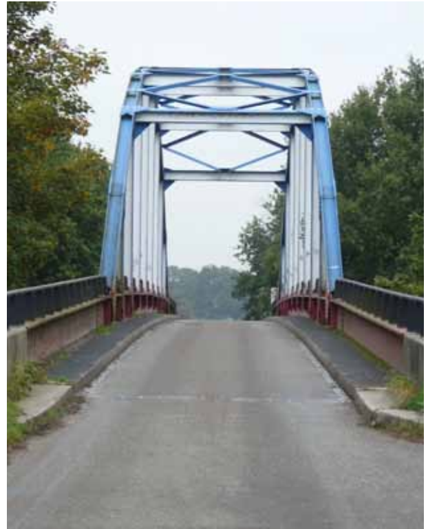
De boogbrug in de Salesdreef is een markante brug vanwege de opvallende kleurstelling.
