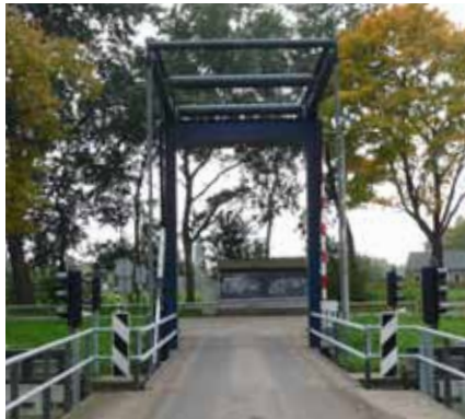
Wederopbouwbrug met hergebruik originele onderdelen.
