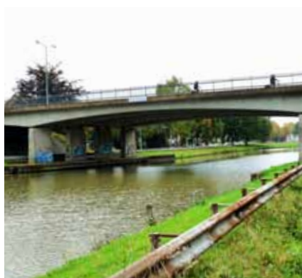
Liggerbrug: de Bredasebrug in Oosterhout.
