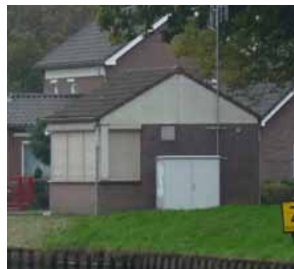
Groter bedieningsgebouw met steiler, hellend dak.
