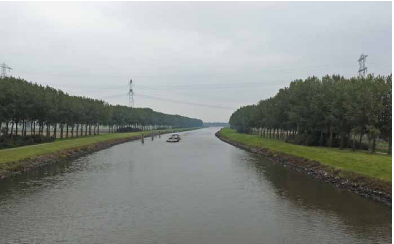
De kanaaldijken langs de Amertak liggen op 3,7 meter +NAP, het omringende polderlandschap ligt op 0 tot 1 meter +NAP.
