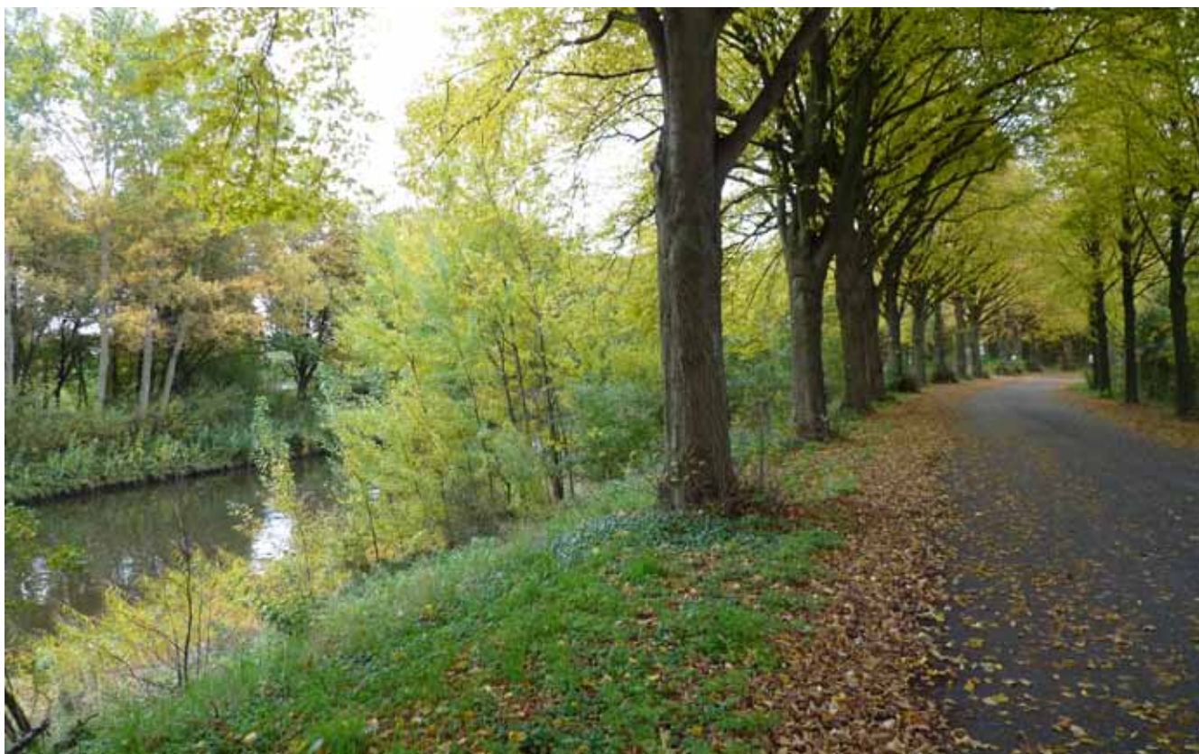
Door de verwerking van vrijgekomen grond uit het kanaal tot kanaaldijken, lijkt het Wilhelminakanaal op sommige plekken diep te zijn ingesneden in het landschap.
