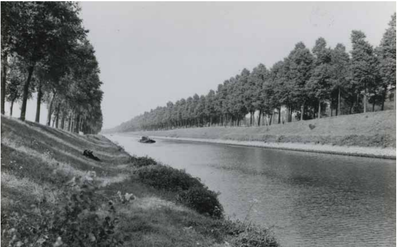
De enige planmatig aangelegde groenstructuur uit de aanlegfase van het kanaal staat langs het oudste deel van het Wilhelminakanaal, bij Oosterhout.
