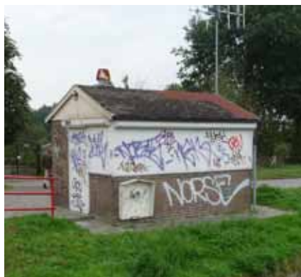
Bedieningsgebouw met flauw hellend dak.
