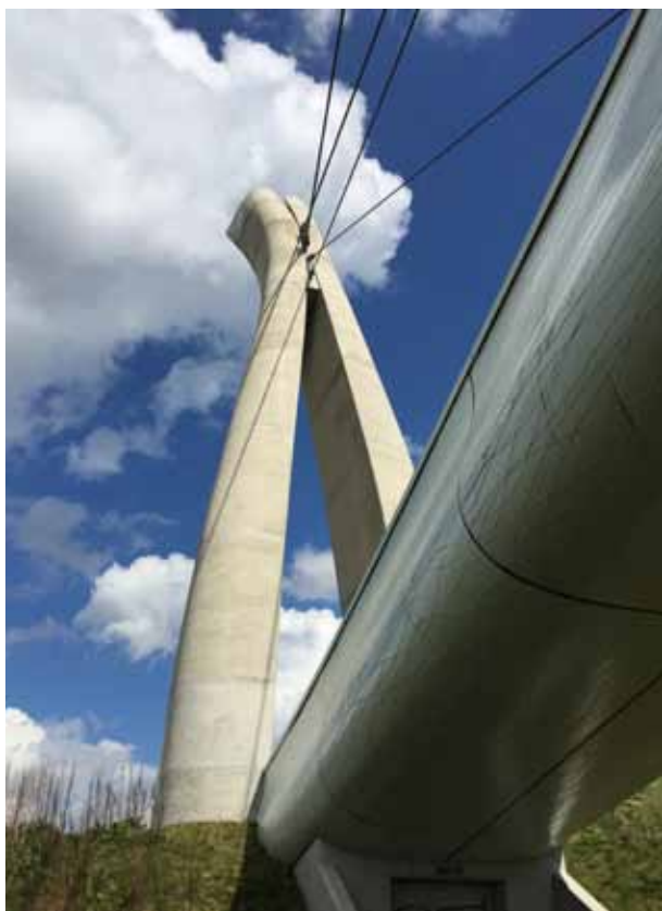
Vanaf de jaren '90 krijgen bruggen een meer in het oog springende vormgeving, zoals hier het ecodeuct naast de Burgemeester Letschertbrug in Tilburg.
