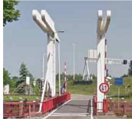
Wederopbouwbrug nieuw gebouwd.
