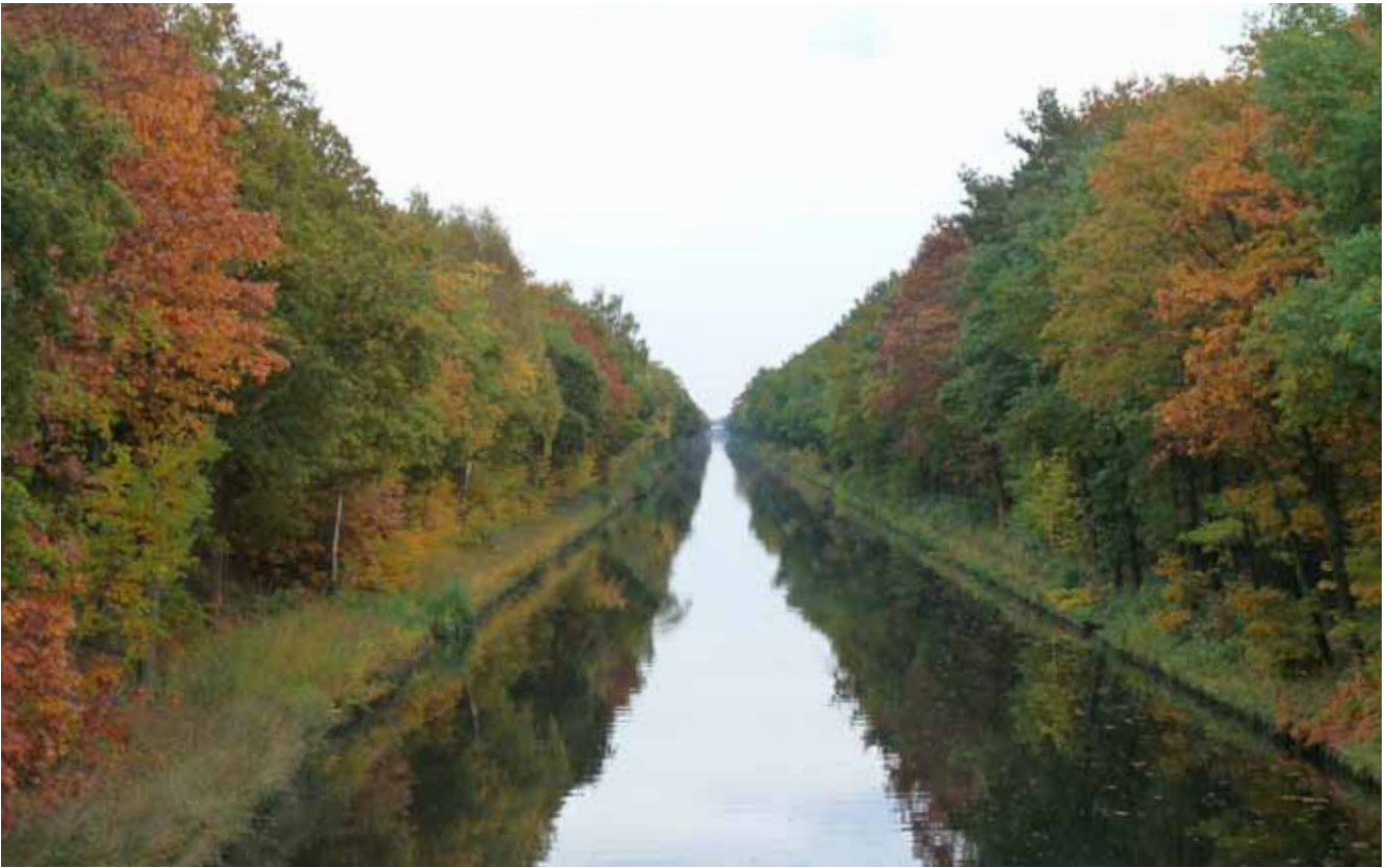
Het Wilhelminakanaal snijdt bij Best door de hogere zandgronden, waardoor de taluds langs het kanaal hier het hoogste niveau bereiken van 21 m +NAP.
