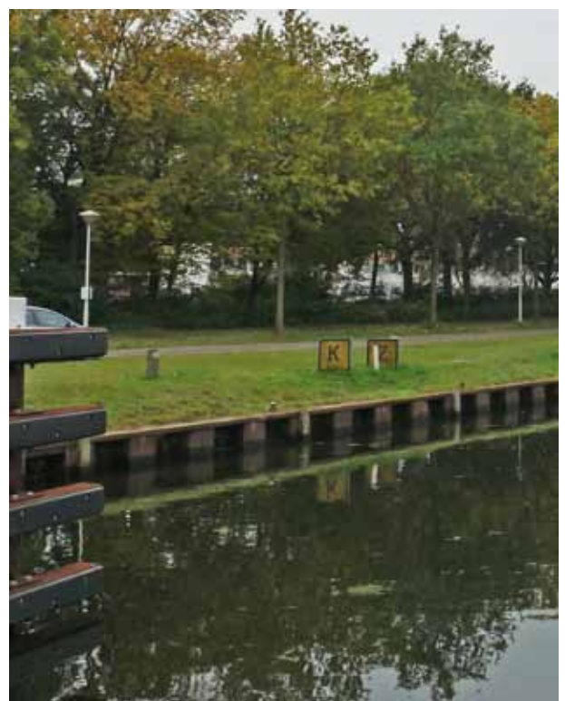
De stalen damwand is in de huidige situatie het meest voorkomende oevertype.
