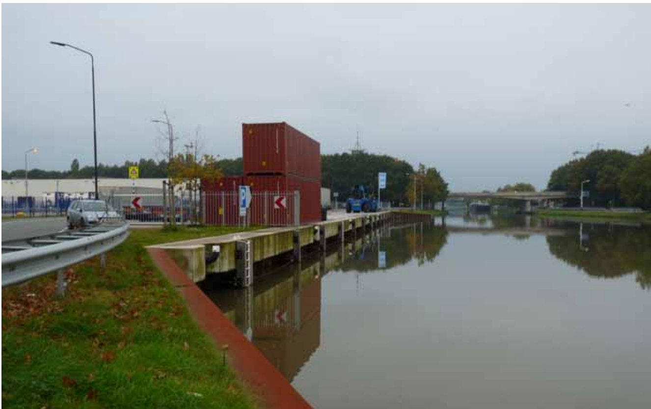
De nieuwste kades aan het Wilhelminakanaal, zoals hier bij industrieterrein Vijf Eiken (Oosterhout), bestaan uit stalen damwanden afgewerkt met een deksloof uit beton.
