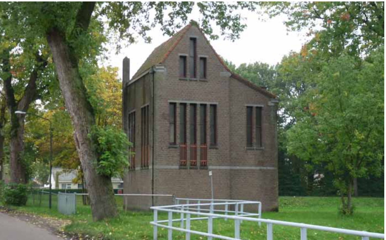
Het schakelhuis-pompstation bij sluis IV diende van origine voor het op peil houden van het hoger gelegen kanaalpand en het compenseren van schutverliezen.
