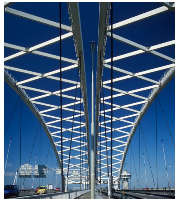
Van Brienoord Bridge
