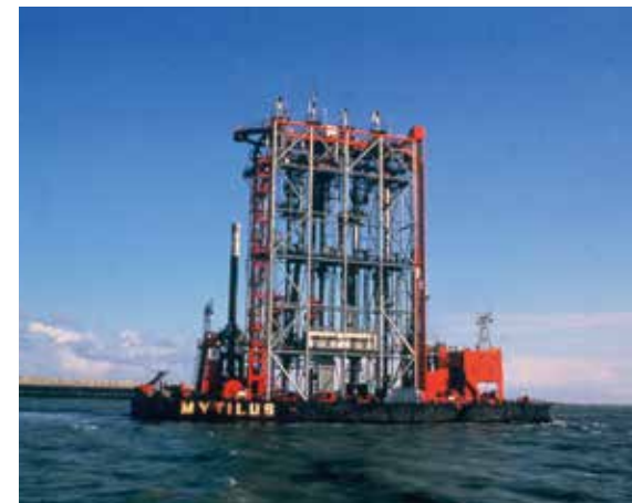
Het verdichtingsschip "Mytilus"
