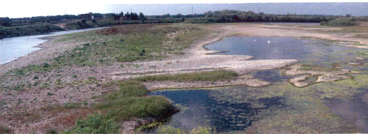
Zicht op de stroomgeulverbreding van het proefproject Meers (situatie 2005).
