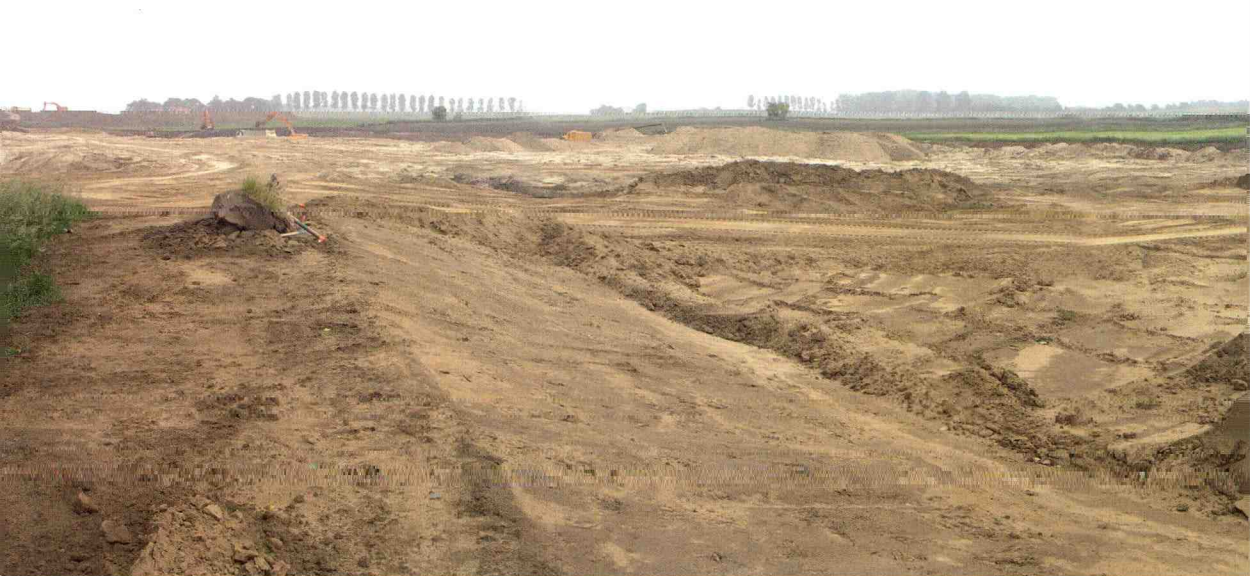
Start van de aanleg van een geul langs de Maas bij Batenburg.
