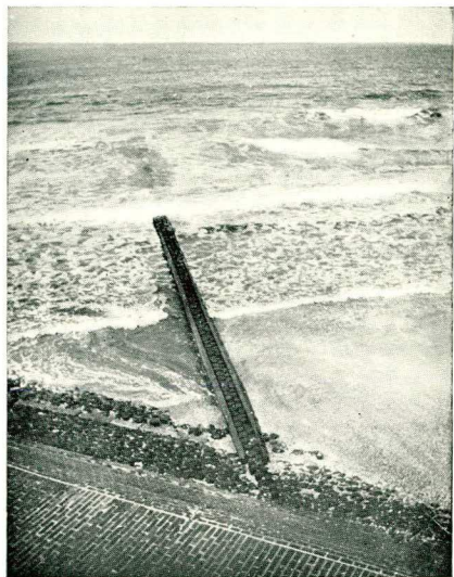
Foto 13. Strandhoofd n o . 4 is in 1931 afgebroken en vervangen door hoofd van ijzeren damwand. Opname 7 Juni 1931, 10 u 30.
