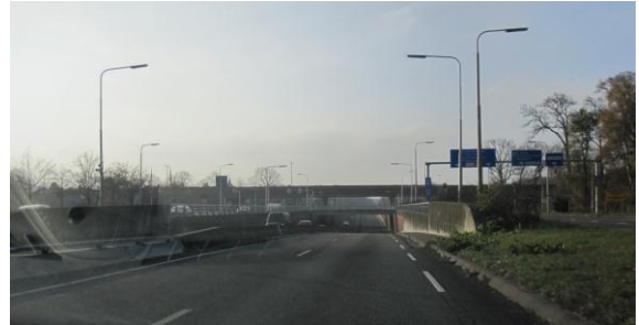
Het kunstwerk in de N14 beperkt deels het zicht op de doorgaand N44.
