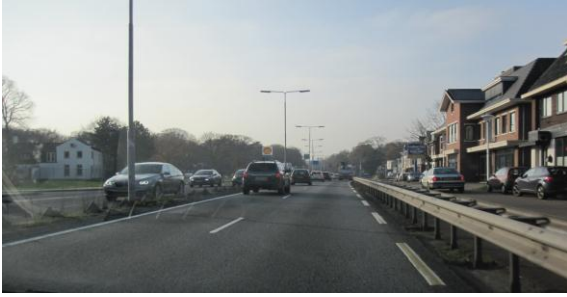
De parallelweg in Wassenaar wordt afgeschermd door middel van geleiderail.
