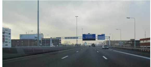
Ter hoogte van afrit 12 Ind. Spaanse Polder wordt het wegbeeld ruimer, onder meer door aanwezigheid vluchtstrook.
