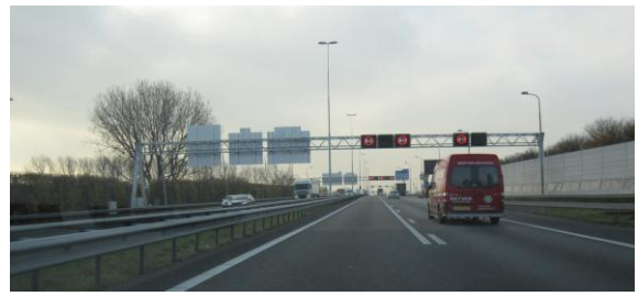
Ter hoogte van de samenvoeging vanaf de A13 vanuit Den Haag is reeds FileProof-markering aanwezig tussen rijstrook 1 en rijstrook 2.
