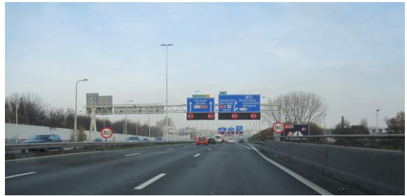
Direct na de Giessenbrug start de uitvoeger naar afrit 13 Overschie.
