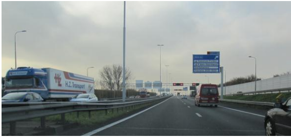
Op 900m stroomopwaarts van afrit 12 Ind. Spaanse Polder staat het eerste vooraankondigingsbord.
