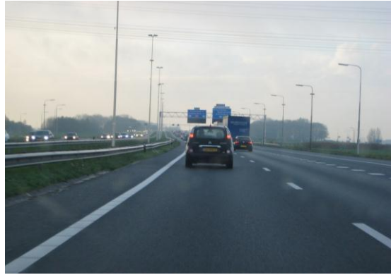
Aansluiting Bunschoten, zicht op stroomafwaarts rijdend verkeer tot op viaduct.
