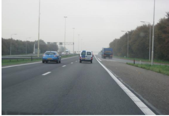
Bepert zicht op verkeer na viaduct over de Eem.
