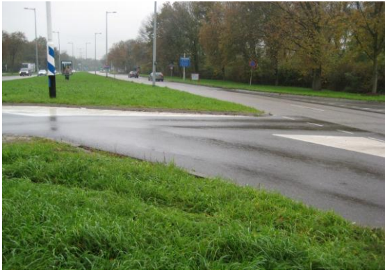
Markering onduidelijk en geen rijlijnen voor de diverse richtingen aanwezig.
