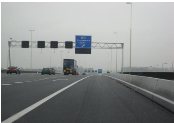
Beperkt zicht op stroomafwaarts rijdend verkeer (signalering aanwezig) - HRL.
