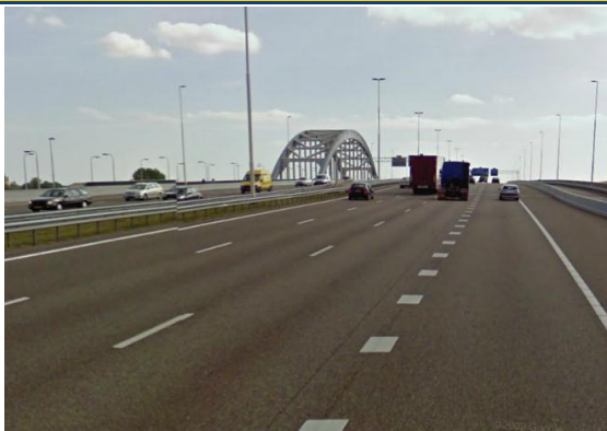
Beperkt zicht op stroomafwaarts rijdend verkeer (signalering aanwezig) - HRR.
