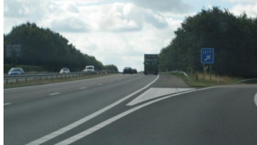
A2 ter hoogte van aansluiting over Kleine Bruggen (visuele vernauwing en beperkt zicht op stroomafwaarts rijdend verkeer).
