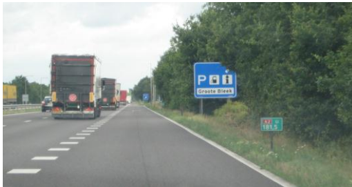
Ontbreken geleiderail tussen afrit naar Groote Bleek en parallelrijbaan (gemeentelijk), tevens veel groen aanwezig in OVZ.
