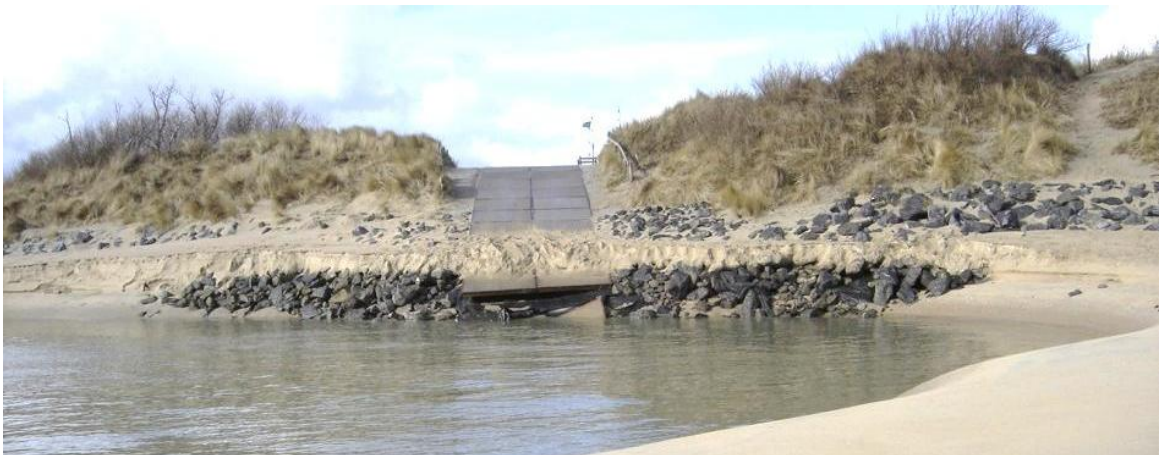
Figuur 4.8 Oeverval aan de kust van Vlieland, ten gevolge van een te steile geul dicht onder de kust.
