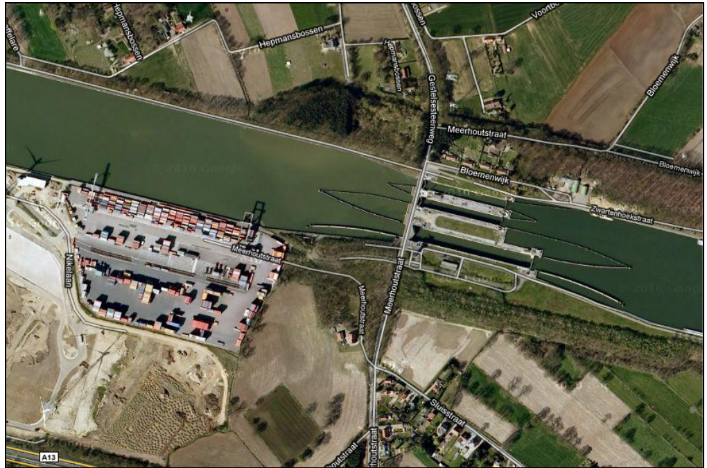
Sluis Meerhout in het Albertkanaal, links de containerterminal Meerhout
