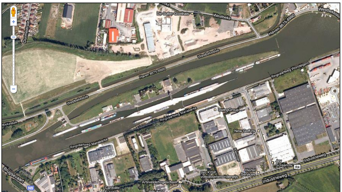
Sluis Evergem nabij Gent
