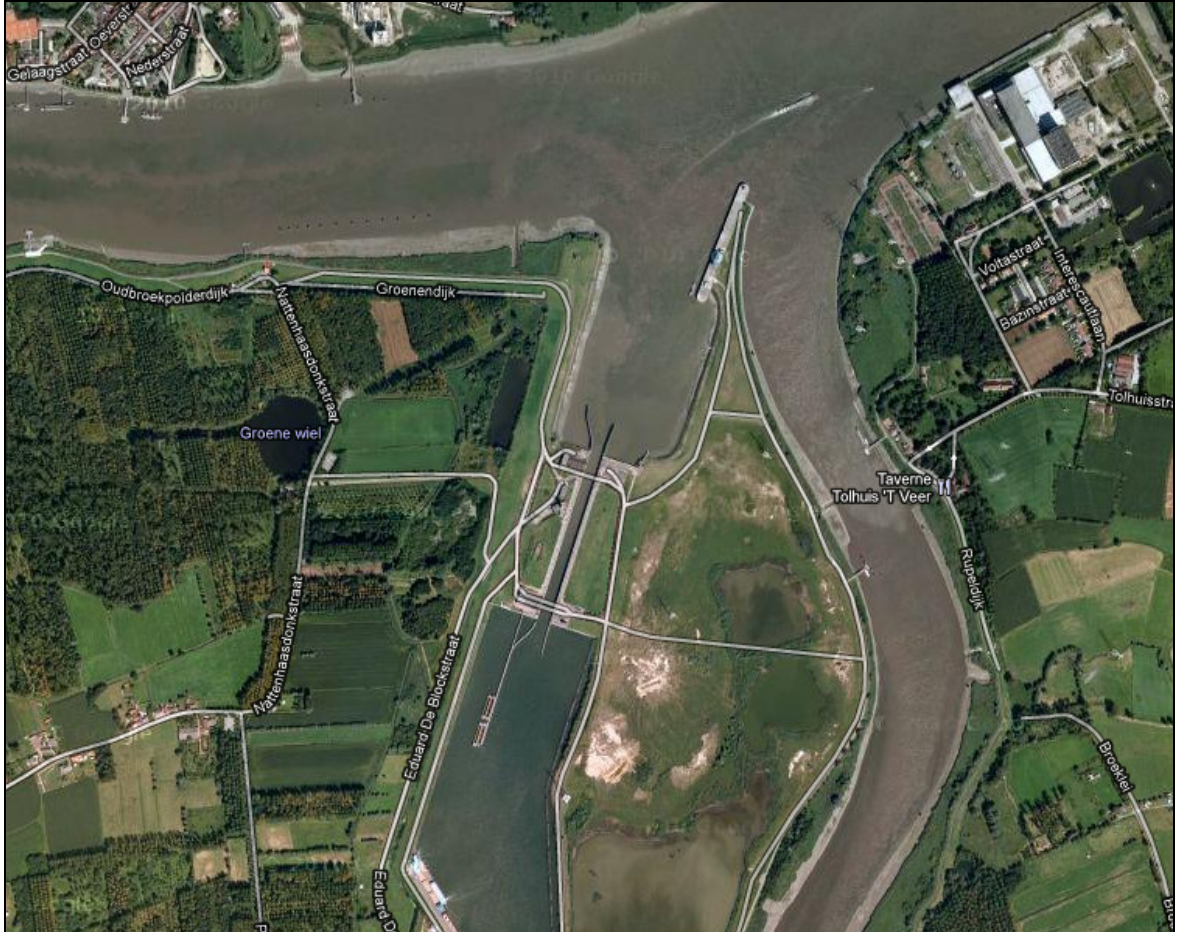
Sluis Wintam in het Zeekanaal naar Brussel op de aansluiting met de Schelde
