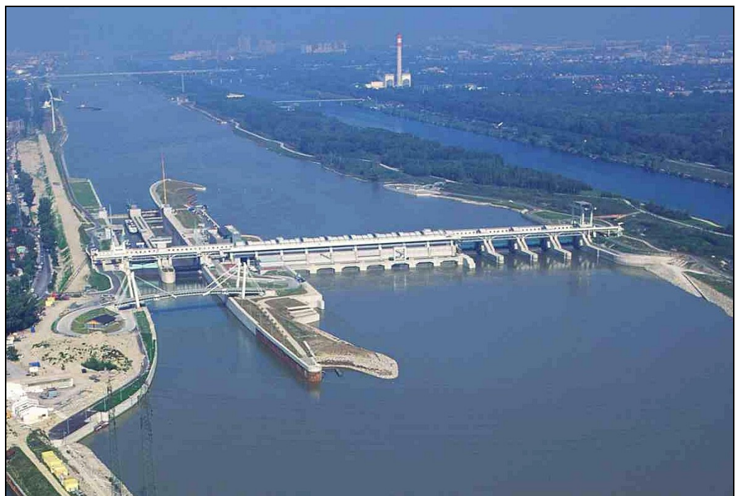
Stuwdam met dubbelsluis Freudenu in de Oostenrijkse Donau
