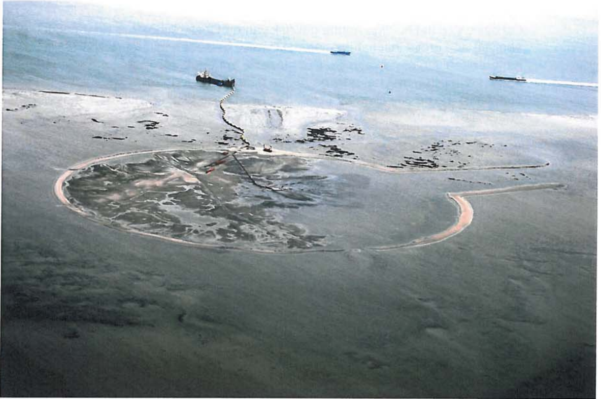
Figuur 2-2: Aanleg suppletie Galgeplaat 24 -9-2008
