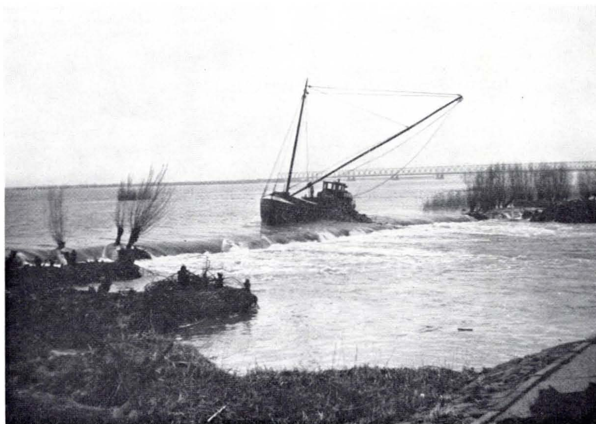
Fig. 4.204. Het storten van steen op de intact gebleven rug van de oeververdediging in het stroomgat ten noorden van Moerdijk, d.d. 9 februari 1953
