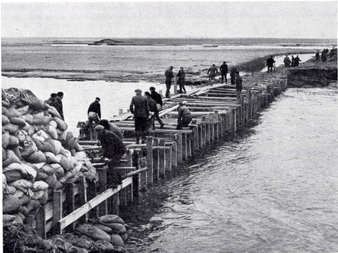
Fig. 4.176. Het dichtten van het noordelijke stroomgat in de hoofdwaterkering van de Willempolder op Sint Philipsland door middel van een kistdam met zand- of kleizakkenvulling. Op de achtergrond het zuidelijke stroomgat in de binnendijk.
