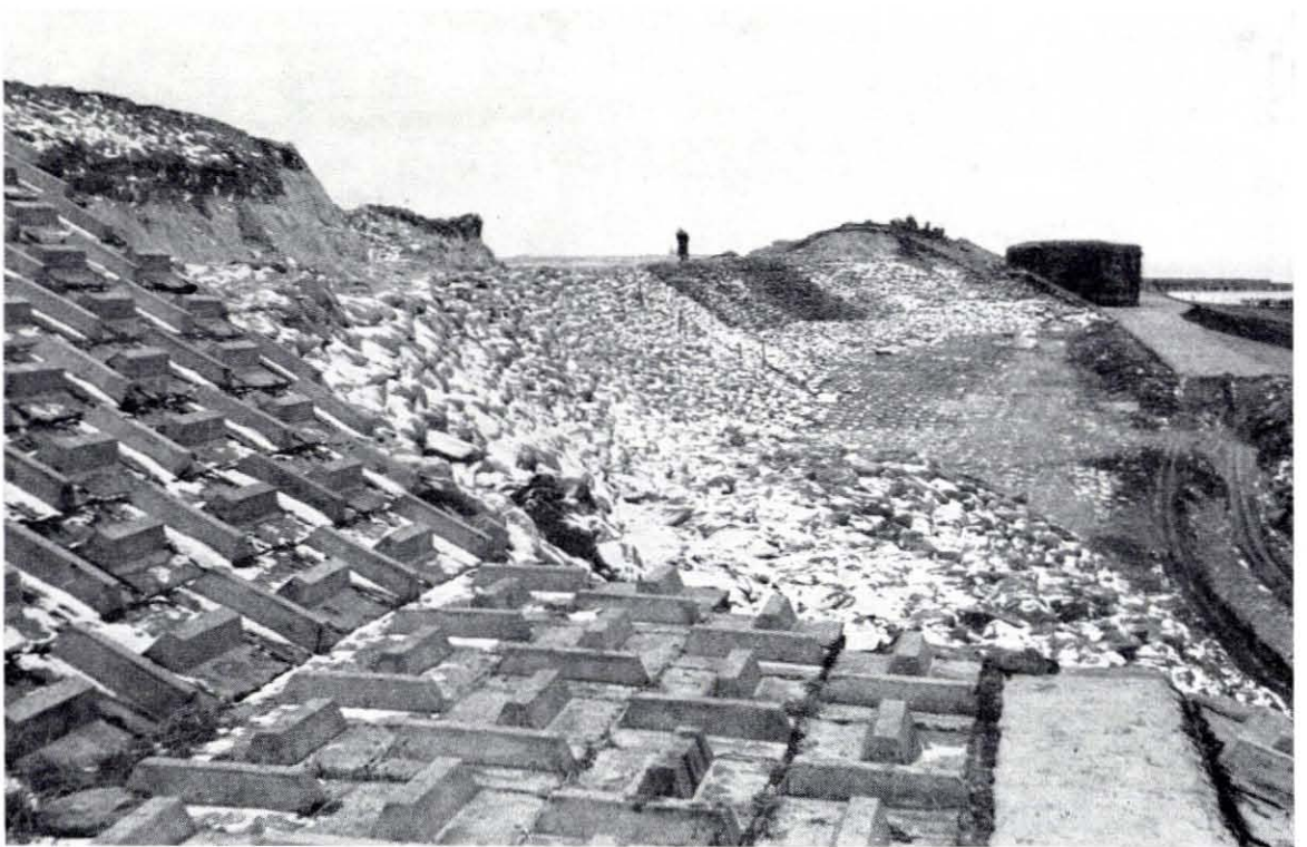
Fig. 4.183. Noodherstel aan de Westkapelse zeewering tussen dp. 38 en strandpaal 1 van de Noordwatering
