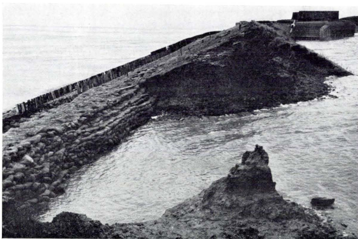
Fig. 4.180. Dichten dijkbres bij dp. 19 + 50 m aan de Zuidwatering met kleizakken
