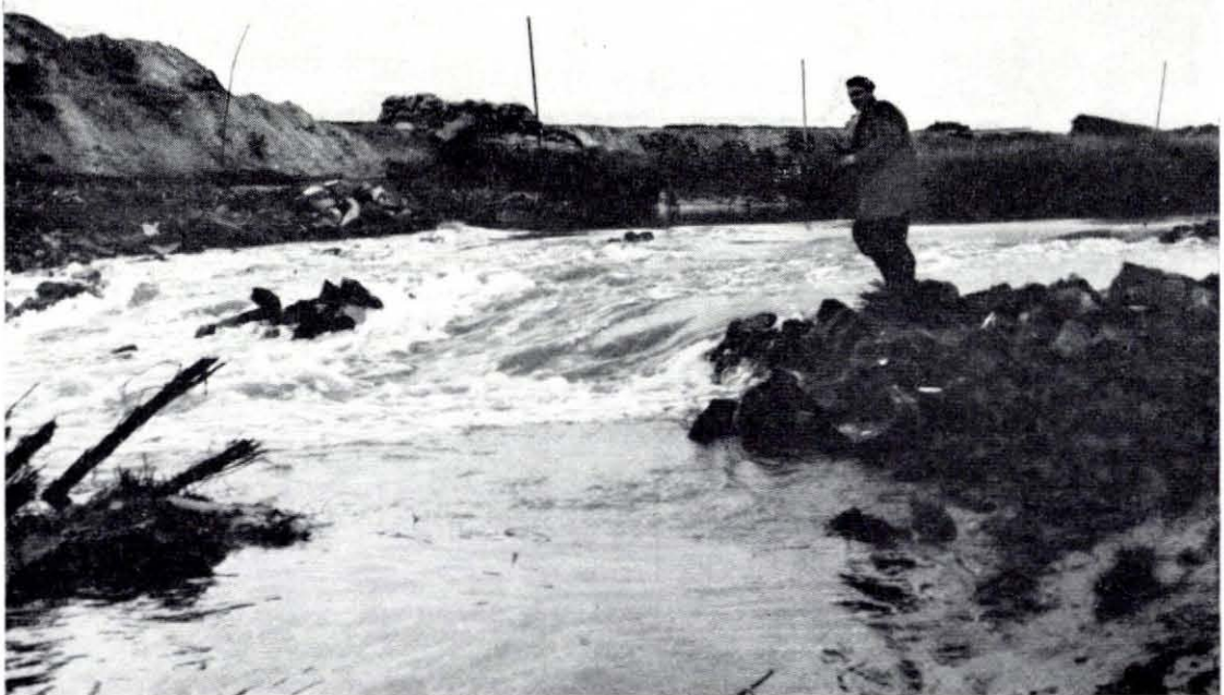
Fig. 4.221. Het afdammen van de Noordkil ten behoeve van de sluiting van het stroomgat in de hoofdwaterkering van de Vijdpolder. Toestand op 12 maart 1953 bij eb. Foto Ir. Israël
