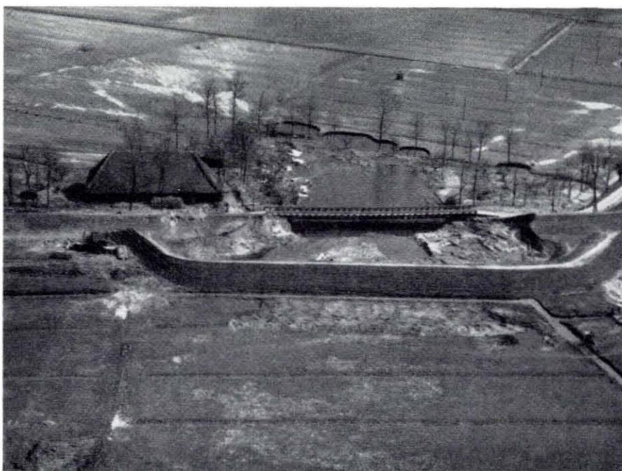
Fig. 4.209. Ringkade om de doorbraak in de hoofdwaterkering van het Waterschap De Ruigenhil nabij het voormalige fort De Hel. De verbinding met Willemstad via de hooggelegen binnenbermweg werd tot stand gebracht door een over de bres gelegde Baileybrug. Foto Aero-Camera
