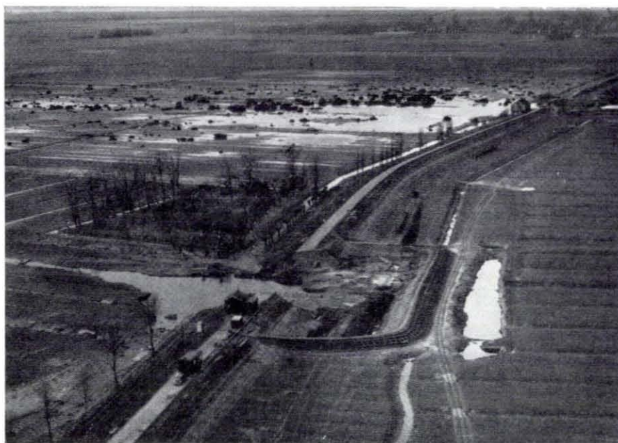
Fig. 4.208. Op de voorgrond de ringkade om de oostelijke doorbraak in de hoofdwaterkering van het Waterschap De Ruigenhil. Op de achtergrond het meer westelijk gelegen stroomgat en de van hieruit in de polder gestroomde veenbonken. Foto Aero-Camera
