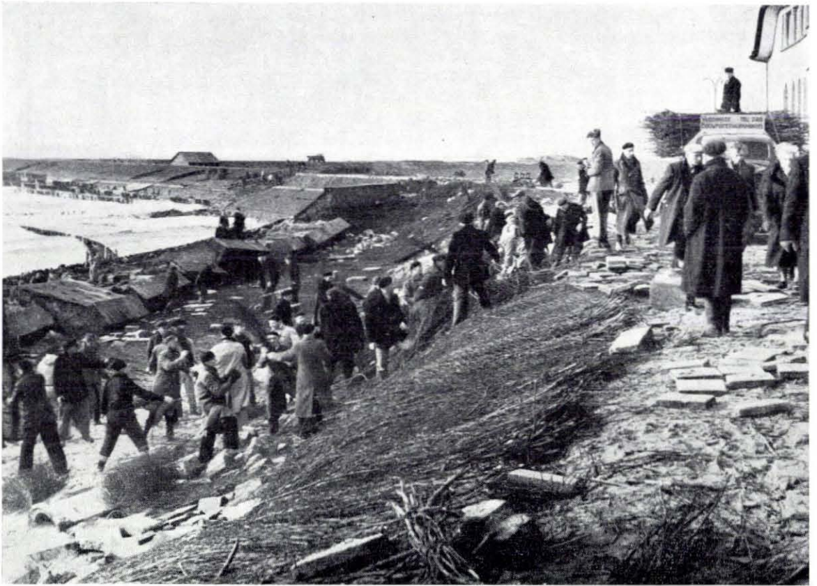
Fig. 4.182. Aanbrengen noodbeslag op de zwaar beschadigde Nollledijk tussen dp. 10 en 12 van de Westwatering te Vlissingen
