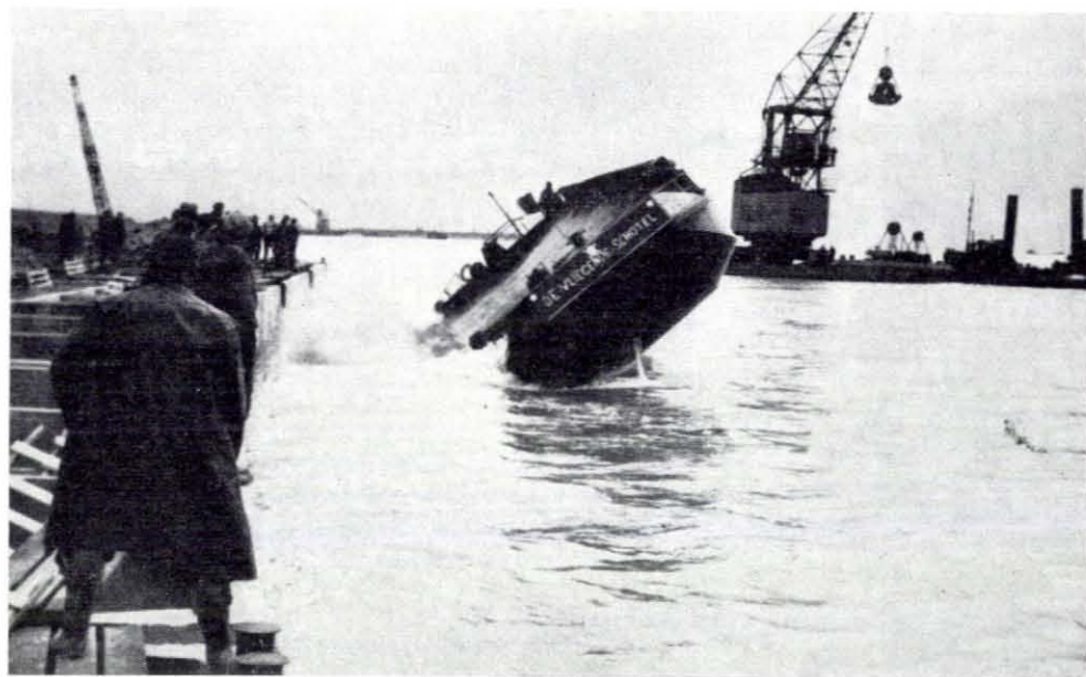
Fig. 4.160. Storten van steen door een kantelbak tegen de zeezijde van het geblokkeerde westgat in de hoofdwaterkering van het Waterschap Kruiningen op 9 mei 1953
