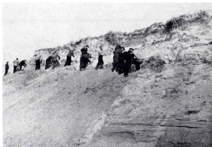
Fig. 4.33. Onder talud brengen van de buitenduinregel onder Wassenaar
