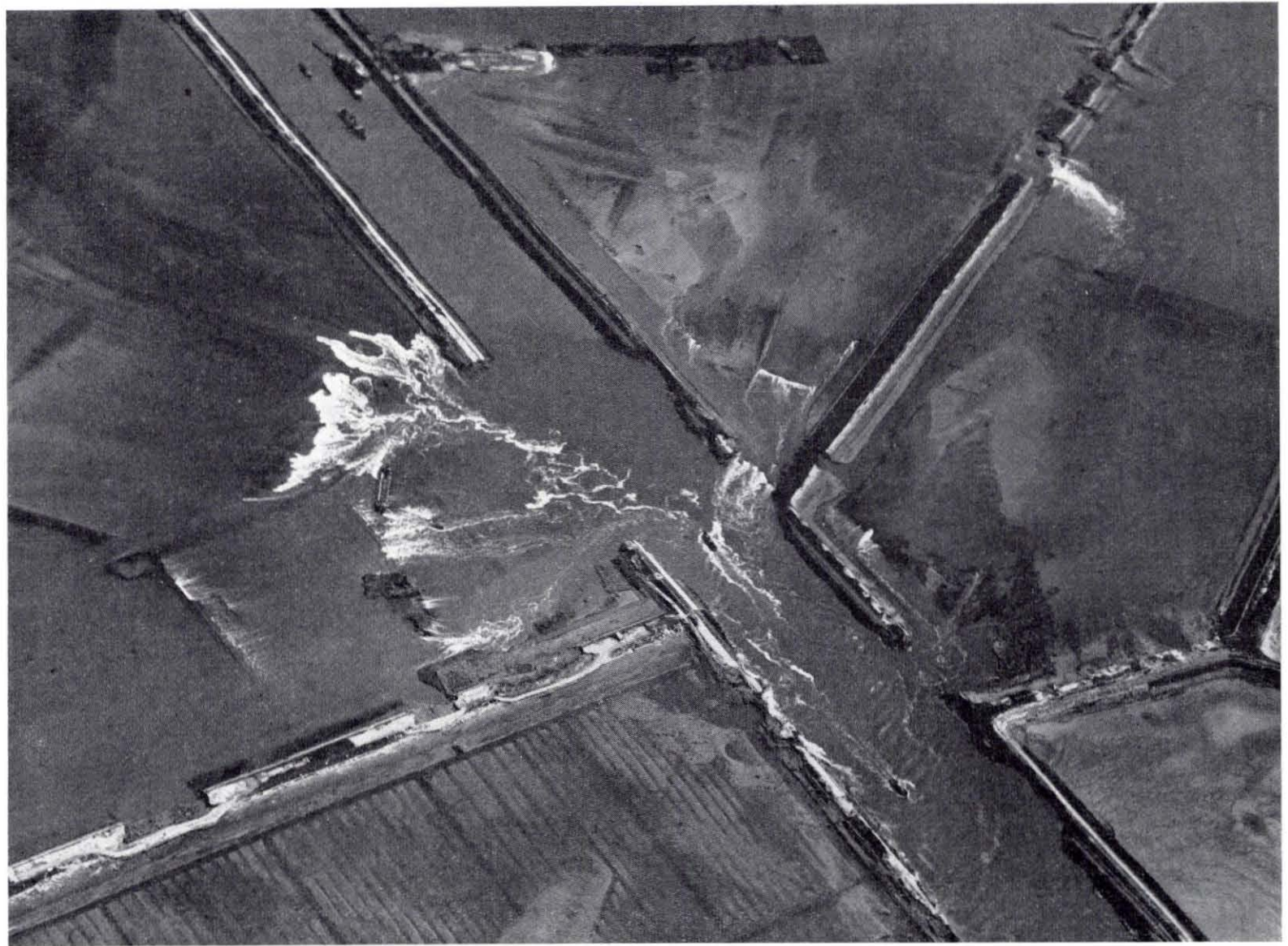
Fig. 4.89. De toestand van de havendammen van Zierikzee op 1 mei 1953. De capaciteit van het stroomgat ten noorden van de gedichte inlaagdijk in de Westelijke havendam is sterk toegenomen. Op de achtergrond de in aanleg zijnde inlaagdijk voor afsluiting van de Polder Zuidhoek van het buitenwater Foto K.L.M.-Aerocarto
