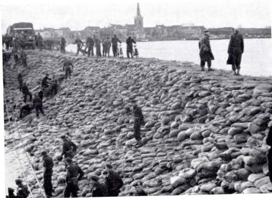
Fig. 4.42. De zandzakkendam in het stroomgat te Ouderkerk aan de IJssel op 3 februari 1953 Foto G. Mul
