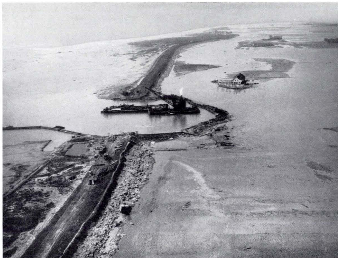
Fig. 4.112. Het aanbrengen van klei op de stenen dam, waarmee het grote stroomgat in de zuidelijke hoofdwaterkering van het Waterschap Ooster- en Sirjansland werd afgesloten, d.d. 21 mei 1953 A.N.P.-foto
