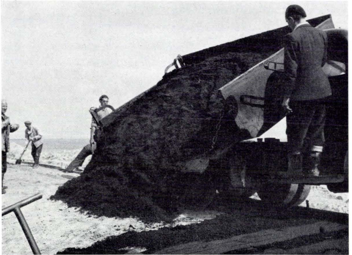
Fig. 4.84. Aanvoer van zandasfalt per kipwagen op de kruin van de dijk
