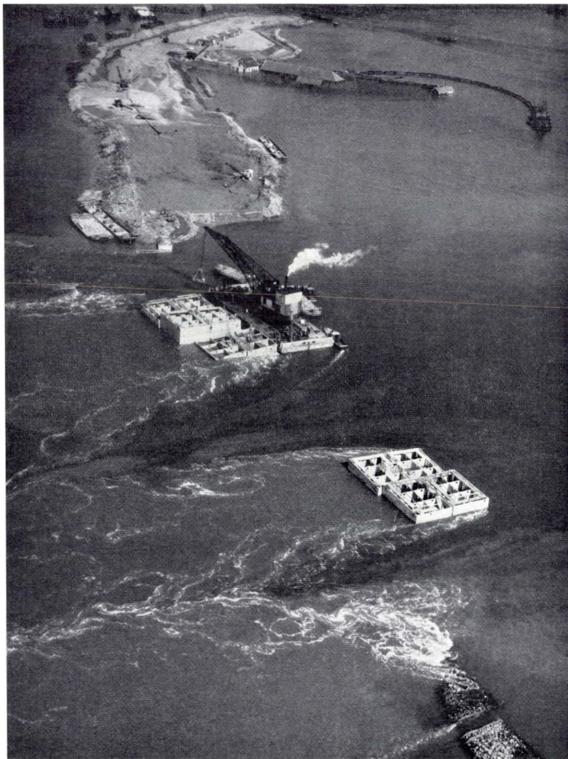
Fig. 4.96. De waterbeweging bij de landhoofden van de Gemene Geul in de inlaagdijk bij Schelphoek bij vloed op 13 augustus 1953. Op de achtergrond het Vogeleiland. Foto Aero-Camera
