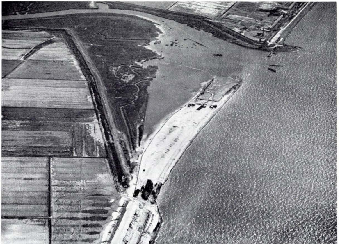
Fig. 4.85. Aanleg dijk met asfaltbekleding door de haven van Oude Tonge
