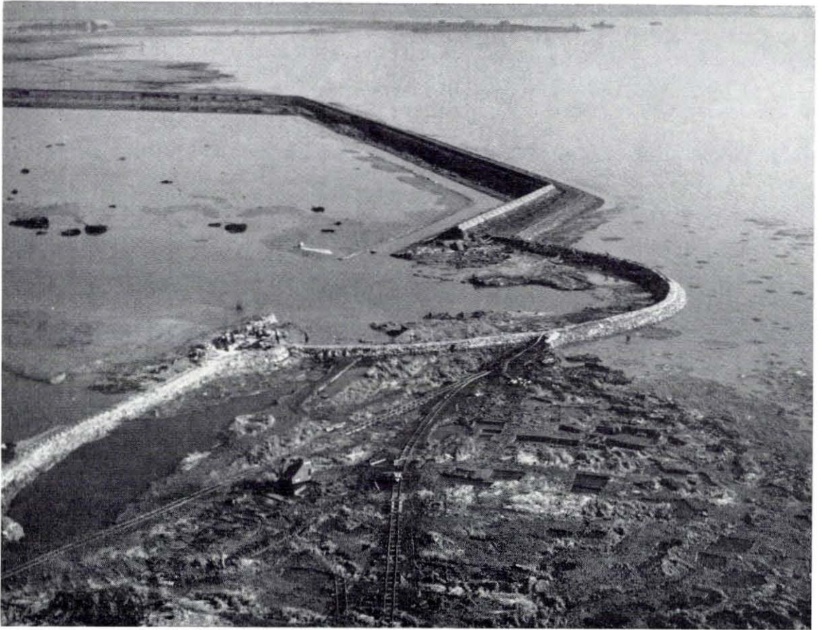
Fig. 4.144. Het gedichte stroomgat in de hoofdwaterkering van de Reigersbergse Polder ten oosten van de Derde Weg door middel van een ringkade over het schor A.N.P.-foto
