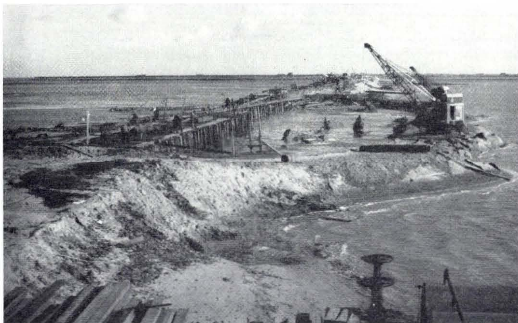
Fig. 4.134. Het maken van de sluitkade aan de polderzijde van de stenen dam d.d. 4 oktober 1954 Foto De Feyter
