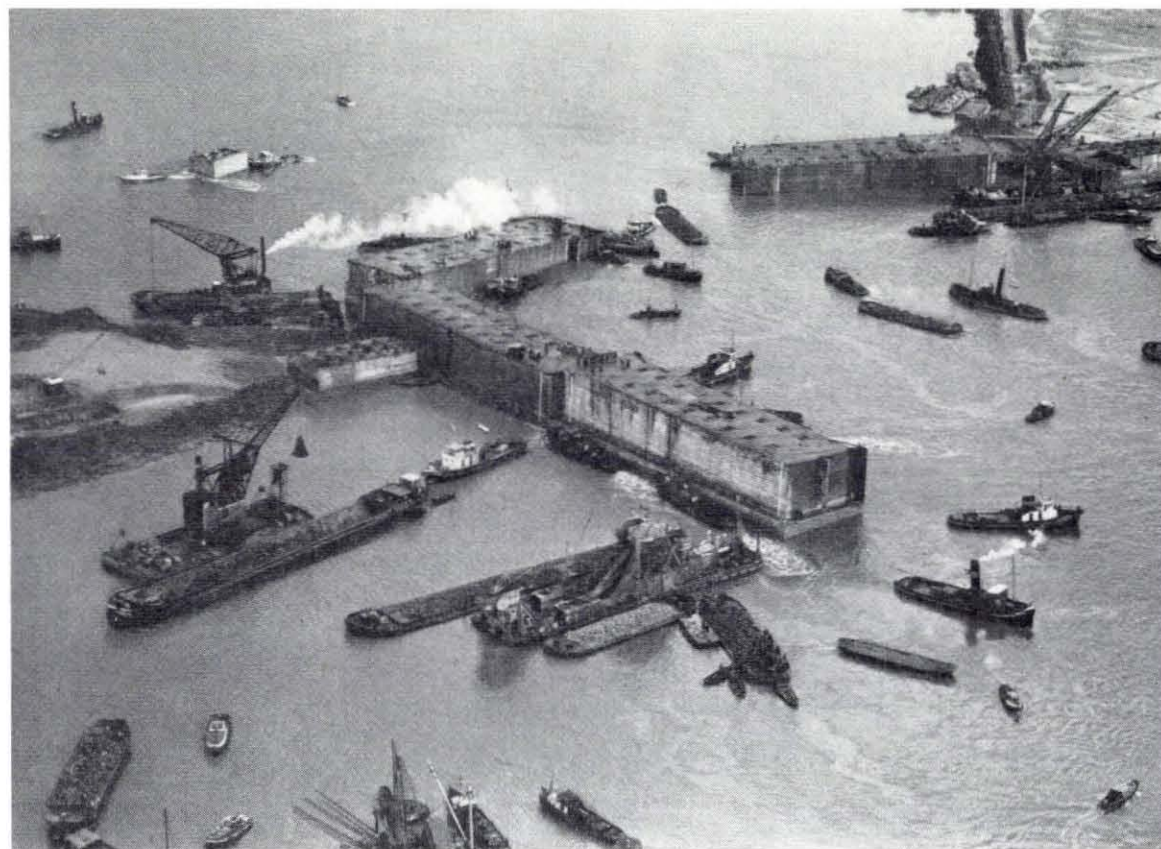
Fig. 4.124. Oostelijk sluitgat ten zuiden van Ouwerkerk op 6 november 1953 gezien vanuit het zuidwesten. De sluitcaisson ligt gemeerd tegen het westelijke landhoofd. De laatste voorbereidselen worden getroffen voor de nachtelijke blokkering. Foto K.L.M. - Aerocarto
