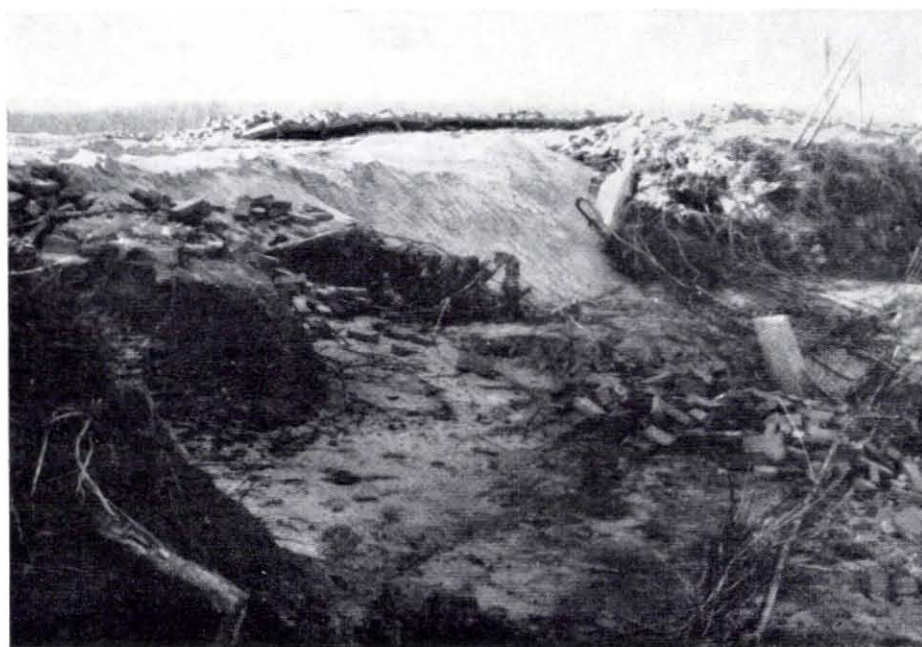
Fig. 4.65. Met zand gedichte doorbraak in de dijk langs de Dordtse Kil van de Oudendijkse polder. Op de achtergrond de omgeslagen betonnen schermwand. Op de voorgrond weggeslagen stenen uit de oude rijksweg.
