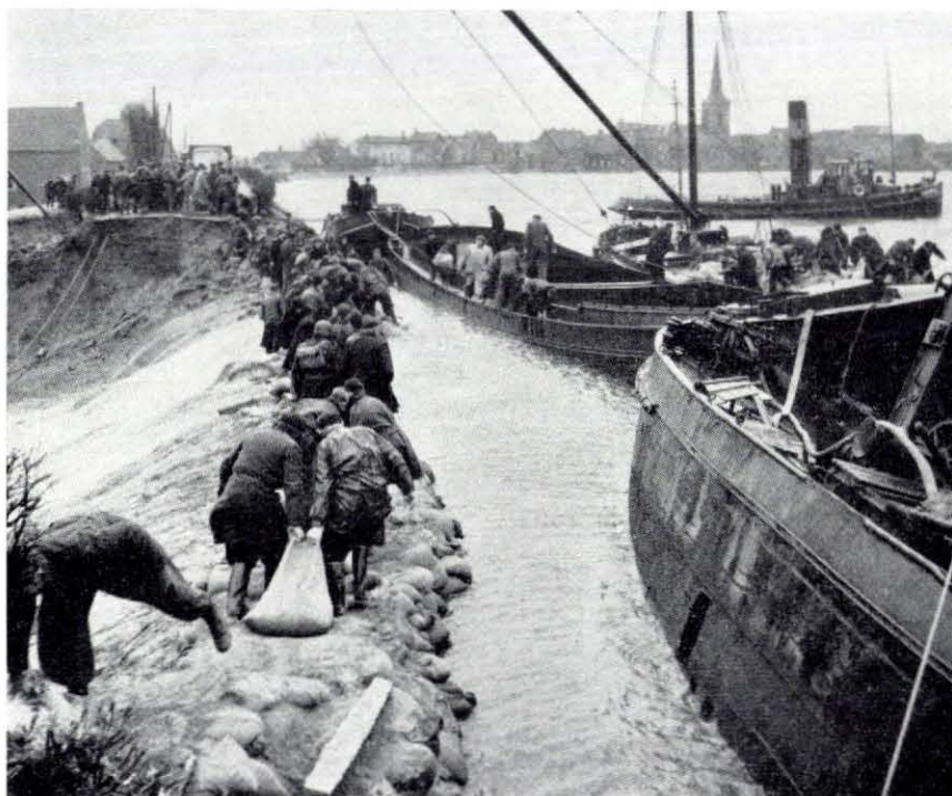
Fig. 4.41. Dichting stroomgat te Ouderkerk aan de IJssel door twee schepen en zandzakendam op 1 februari 1953 Foto Particam Pictures
