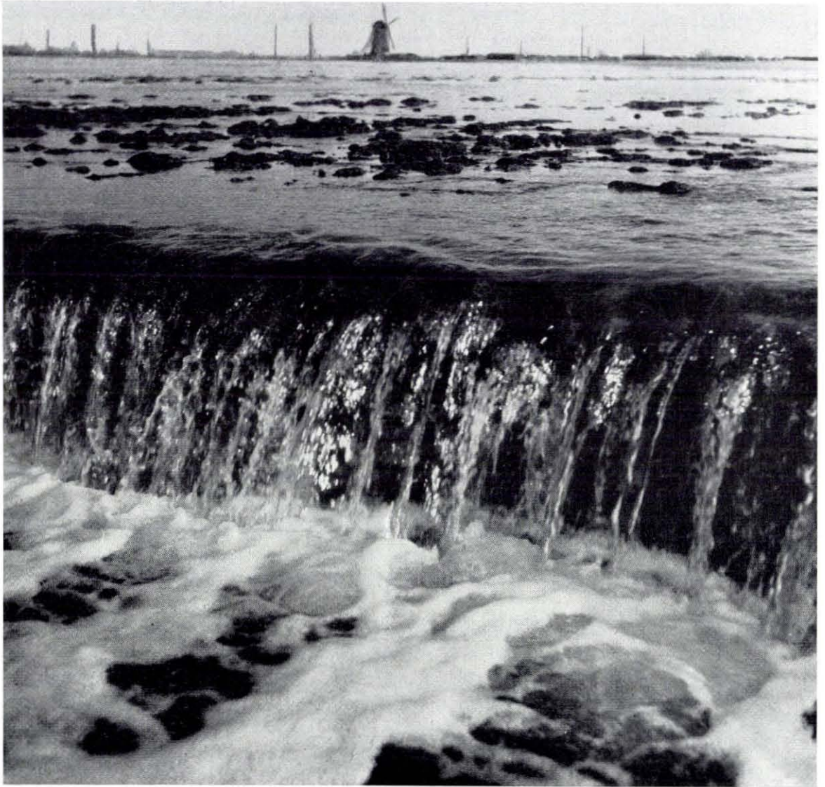
Fig. 4.117. Bij eb vormt het uitstromende water aan het einde van de geulen in de polder kleine watervallen, waardoor het geulensysteem zich steeds verder landwaarts uitbreidt. Op de achtergrond de nog niet ingestorte molen van Ouwerkerk. Foto Particam Pictures, d.d. 23 april 1953
