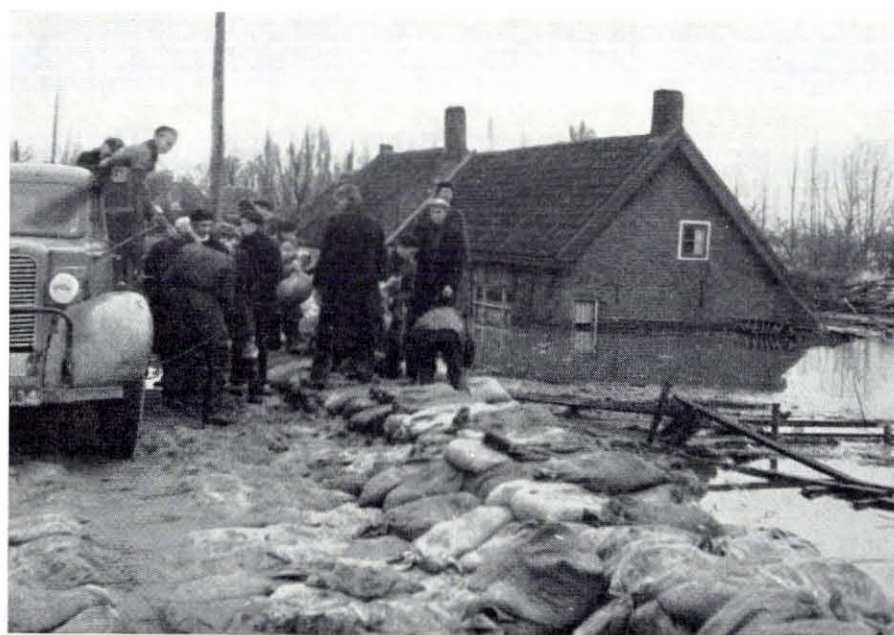
Fig. 4.62. Het verhogen van de binnendijk tussen Strijen en Maasdam met zandzakken op 3 februari 1953 Foto Arbeiderspers
