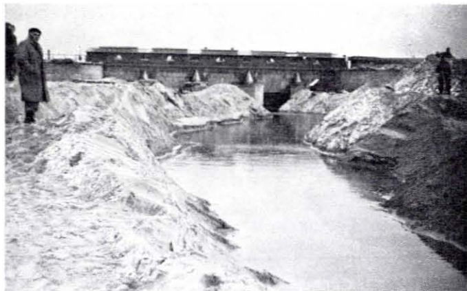
Fig. 4.37. Het uitdiepen van de met zand volgeslagen uitwateringsgeul van het gemaal te Katwijk
