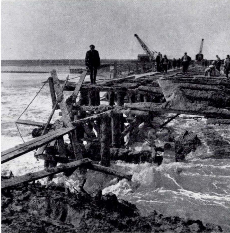
Fig. 4.133. De doorbraak van de gevulde kleikist bij de oostkop van het sluitgat even voor hoogwater d.d. 26 augustus 1954 te 14 uur Foto Ir. G. H. S. Hofker
