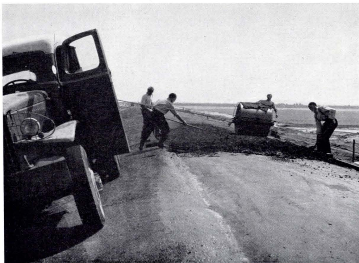
Fig. 4.83. Spreiden van de 10 cm dikke laag asfaltbeton op de kruin en het afwalsen
