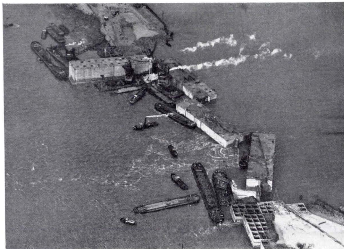
Fig. 4.125. Overzicht van de geslaagde blokkering met vier Phoenixcaissons van het oostelijke sluitgat ten zuiden van Ouwerkerk, d.d. 7 november 1953
