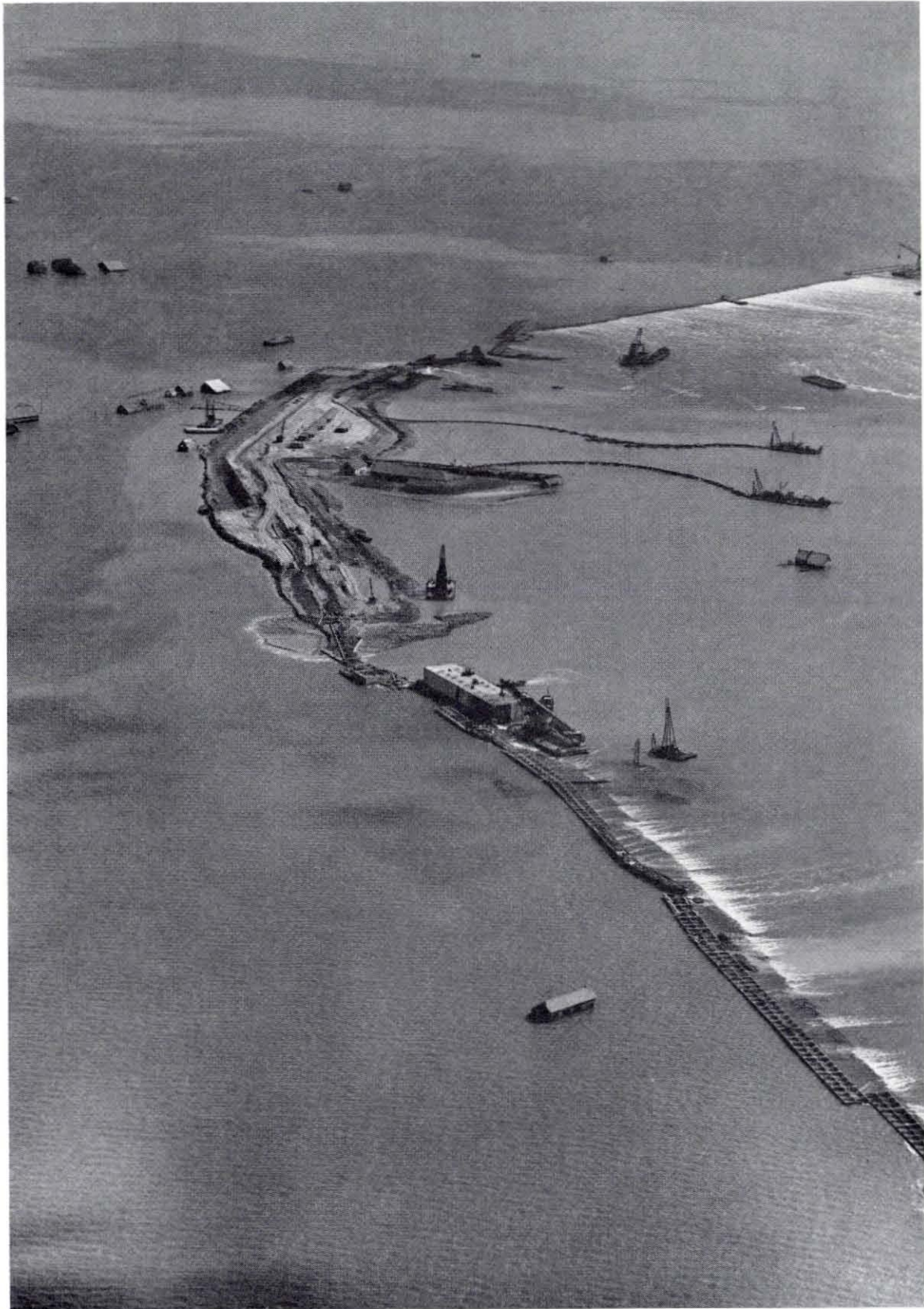
Fig. 4.98. Het Vogeleiland met aansluitende caissondammen van de inlaagdijk bij Schelphoek op 26 augustus 1953. Op de voorgrond de met een Phoenixcaisson geblokeerde Gemeene Geul en gebruikte zinkschepen. Bij eb stroomt het water uit de polder over de caissondam en door talloze lekken er onder door.
