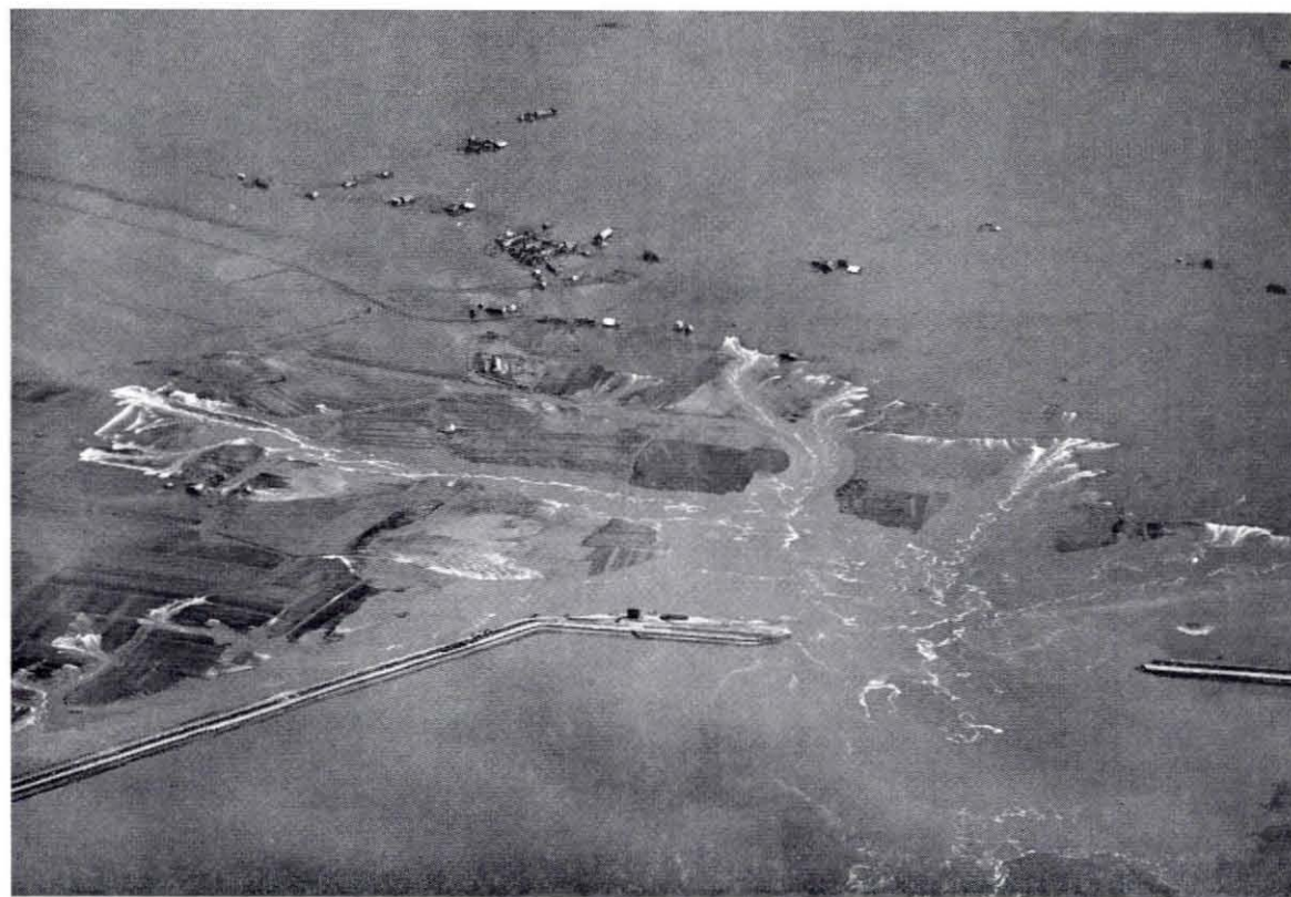
Fig. 4.91. Het stroomgat te Schelphoek bij laagwater op 1 mei 1953. Duidelijk is de ontwikkeling te zien van de geulen in de polder ten gevolge van de terugschrijdende erosie.
