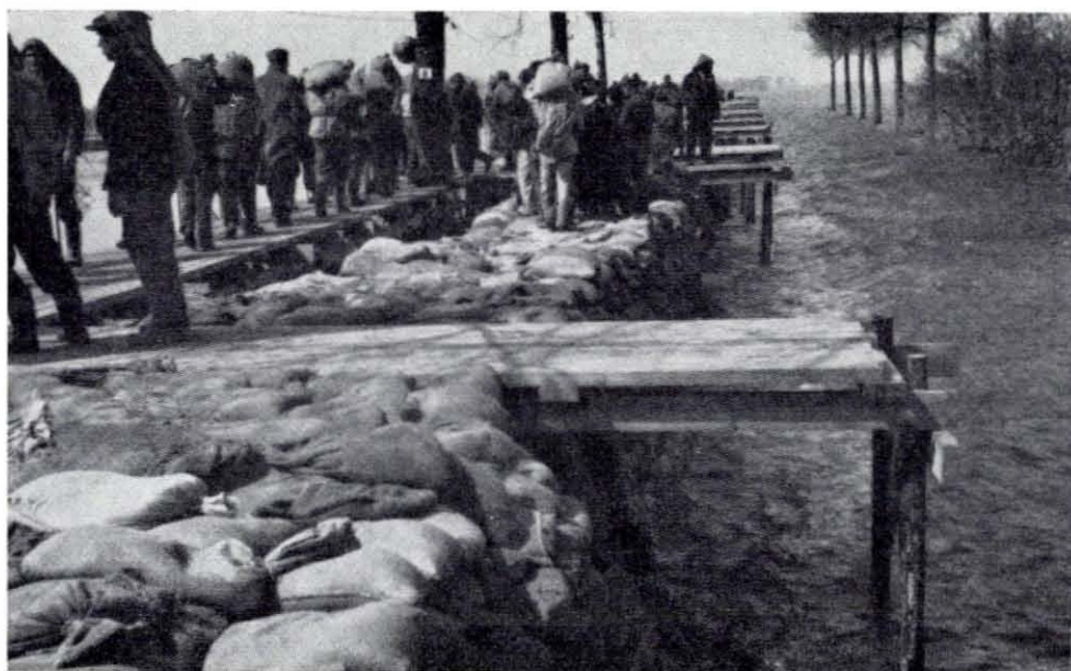
Fig. 4.158. Sluiting zandzakkenkade op de rijksweg op 23 april 1953 ten behoeve van herstel Kadijk-Lavendeldijk Foto Kruithof
