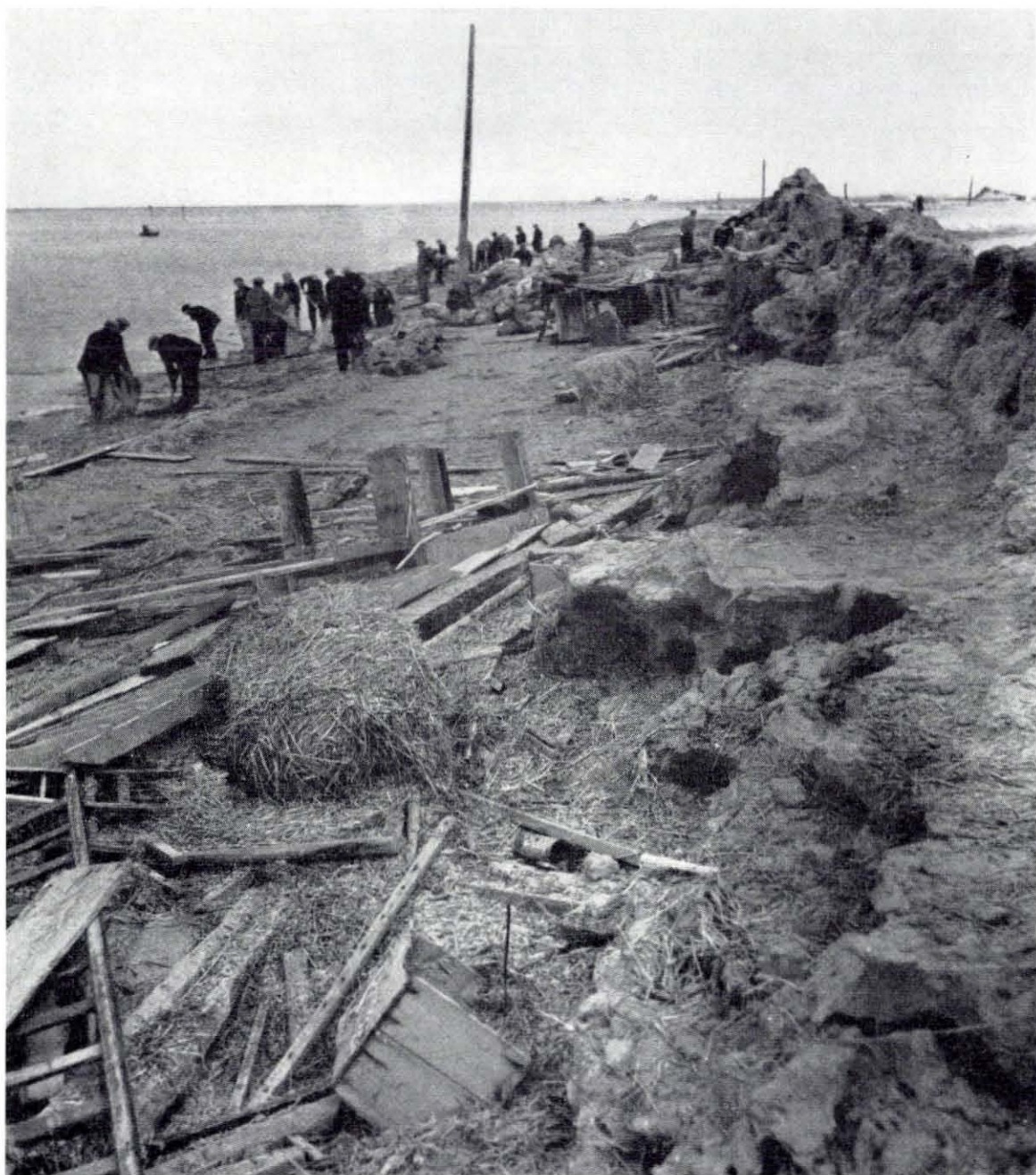
Fig. 4.113. De toestand van de door golfslag en getij zwaar beschadigde Rampaartse Dijk op 23 april 1953
