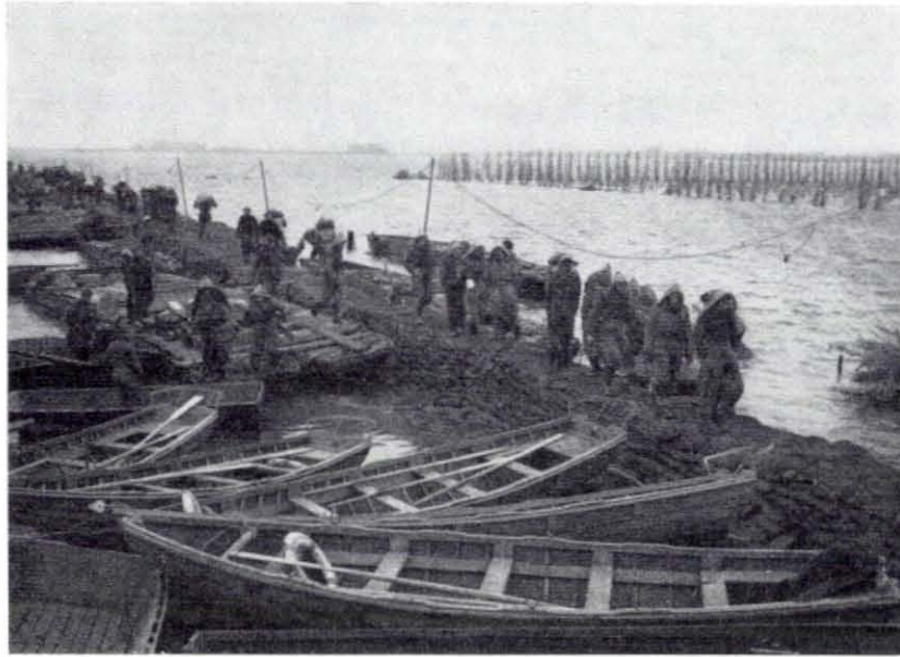
Fig. 4.146. Werkzaamheden aan de Vierde Weg in de Reigersbergse Polder. Vervoer van zandzakken met pontons en aanvalsboten in de sloten langs de weg bij laagwater. A.N.P.-foto
