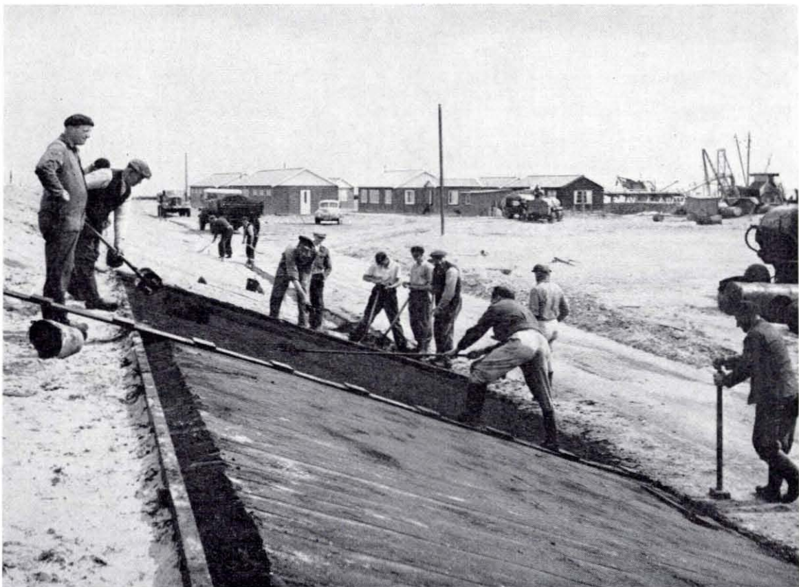
Fig. 4.81. Het vlakstrijken van en bijwerken van oneffenheden in de aangebrachte laag zandasfalt. Het verdichten heeft plaats via stamschotten.
