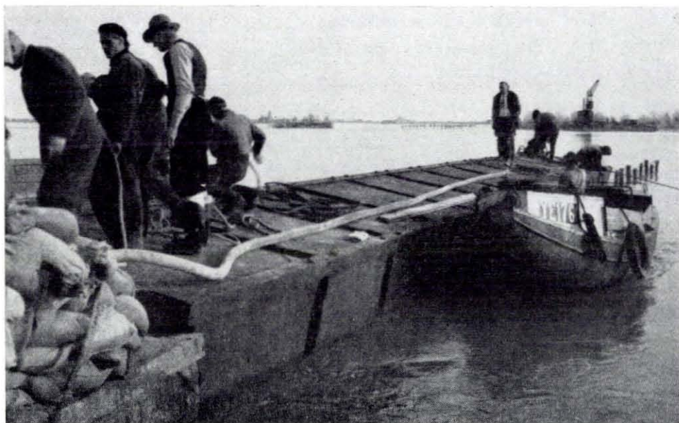
Fig. 4.155. Zinken van een N.L.-ponton door volpompen met water ten behoeve van het herstel van de Kadijk Foto Kruithof
