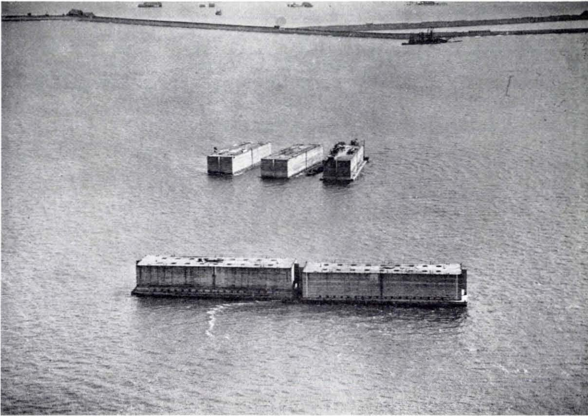
Fig. 4.21. Ligplaats van Phoenixcaissons type AX op de Nunneplaat in de Oosterschelde. Op de achtergrond de zuidelijke zeedijk van het waterschap Schouwen Foto K.L.M.-Aerocarto
