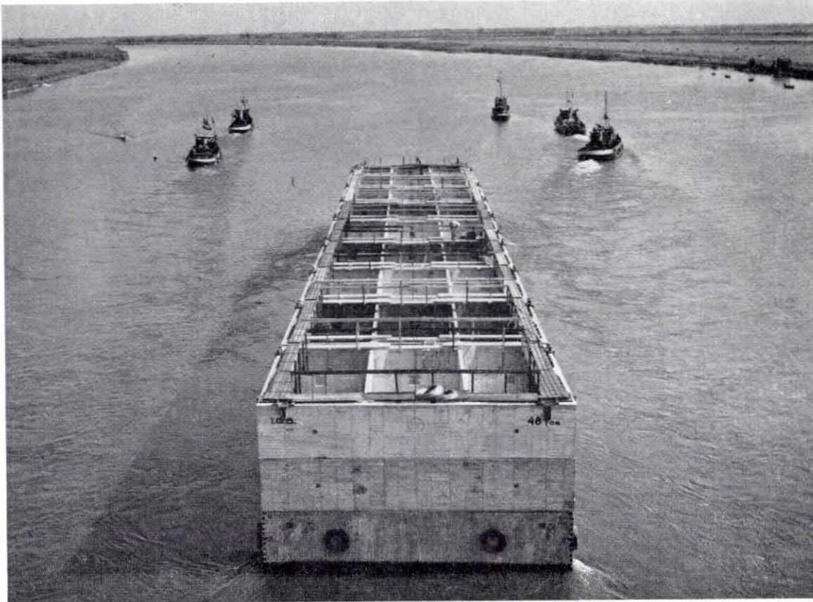
Fig. 4.16. Het transport van een 10 m hoge, samengestelde eenheidscaisson in de Oude Maas op weg naar het rampgebied Foto Tom Kroeze
