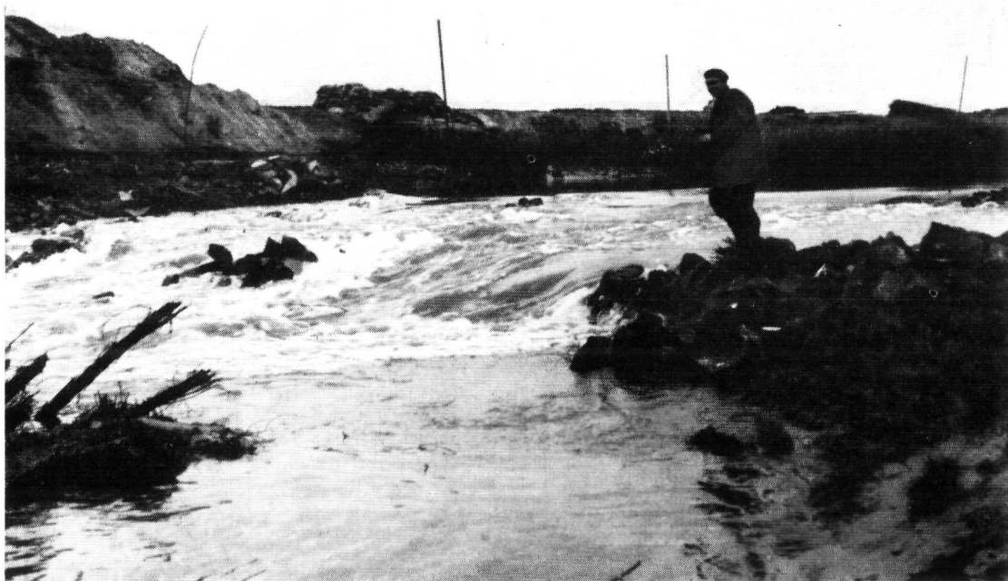
Fig. 4.221. Het afdammen van de Noordkil ten behoeve van de sluiting van het stroomgat in de hoofdwaterkering van de Vijdpolder. Toestand op 12 maart 1953 bij eb. Foto Ir. Israël
