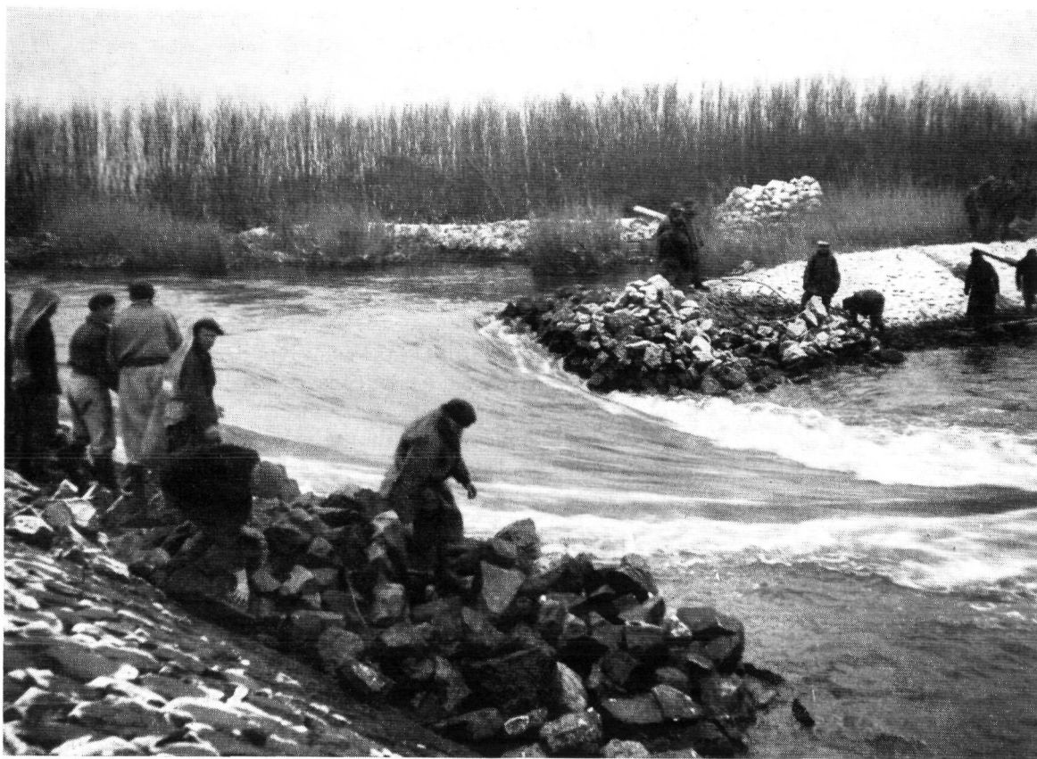
Fig. 4.203. Dichting stroomgat in de hoofdwaterkering van het Waterschap De Royale Polder ten oosten van de Moerdijkbruggen. Ebstroom over de in aanleg zijnde stenen dam in de mond van de suatiegeul van de Vegetassluis, d.d. 14 februari 1953. Foto Ir. Israël
