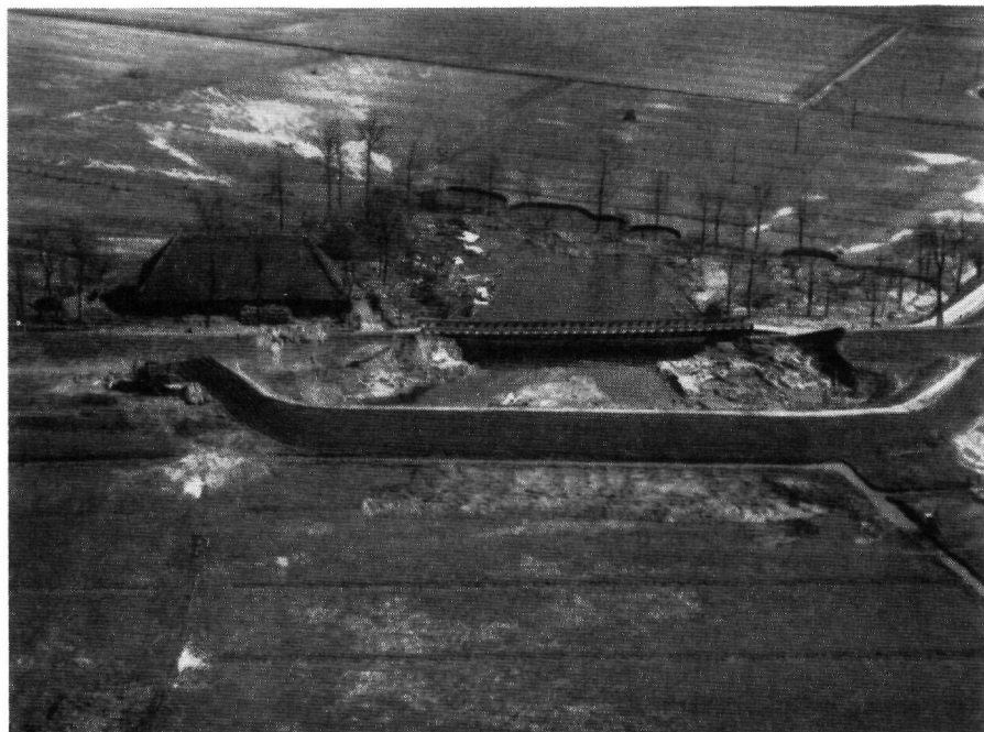
Fig. 4.209. Ringkade om de doorbraak in de hoofdwaterkering van het Waterschap De Ruigenhil nabij het voormalige fort De Hel. De verbinding met Willemstad via de hooggelegen binnenbermweg werd tot stand gebracht door een over de bres gelegde Baileybrug. Foto Aero-Camera
