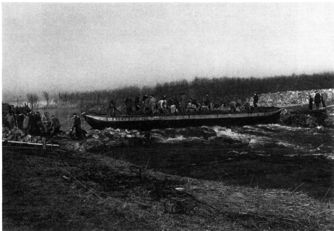
Fig. 4.207. Aanleg van een stenen dam in de voormalige suatiegeul vóór het stroomgat in de hoofdwaterkering van het Waterschap De Ruigenhil ten oosten van Willemstad, d.d. 3 maart 1953 Foto De Arbeiderspers
