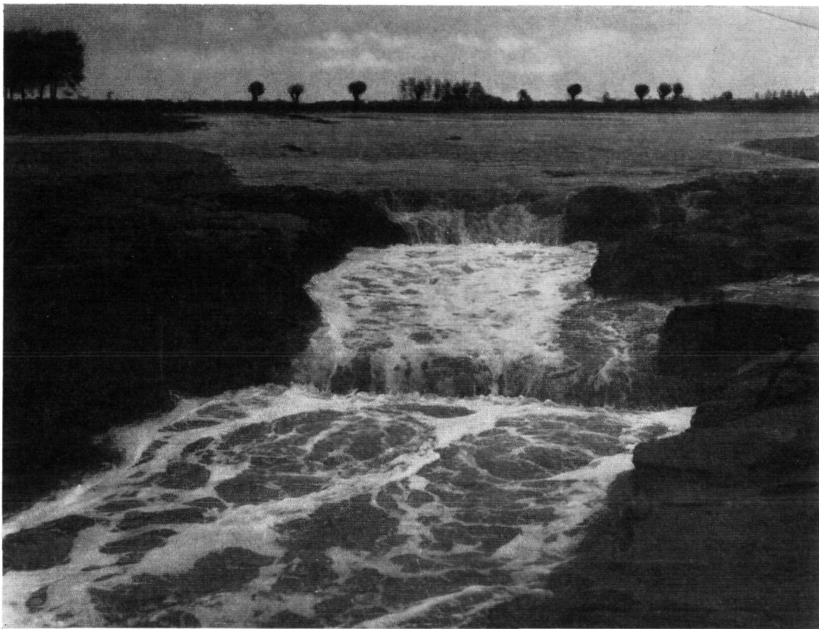
Fig. 4.164. Vorming van de Inkelgeul in het Waterschap Kruiningen door terugschrijdende erosie
