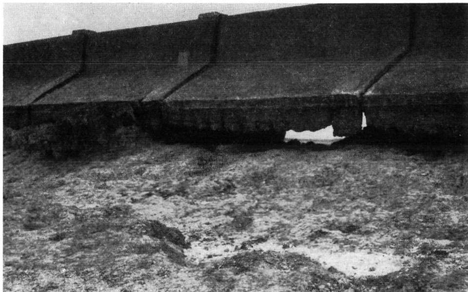
Fig. 4.196. Door golfploop en wateroverslag onderloops geworden Muraltmuur op de hoofdwaterkering van de Nijspolder Foto Rijkswaterstaat
