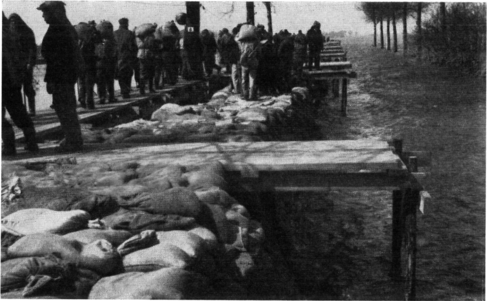
Fig. 4.158. Sluiting zandzakkenkade op de rijksweg op 23 april 1953 ten behoeve van herstel Kadijk-Lavendeldijk Foto Kruithof
