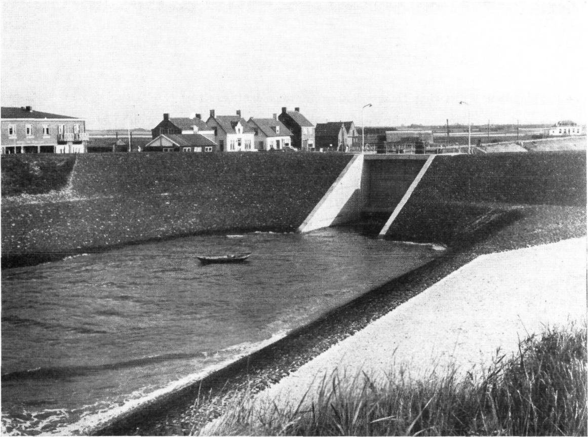
Fig. 4.189. Buitenhoofd van de nieuwgebouwde sluis aan de Wielingen van het Waterschap Het Vrije van Sluis
