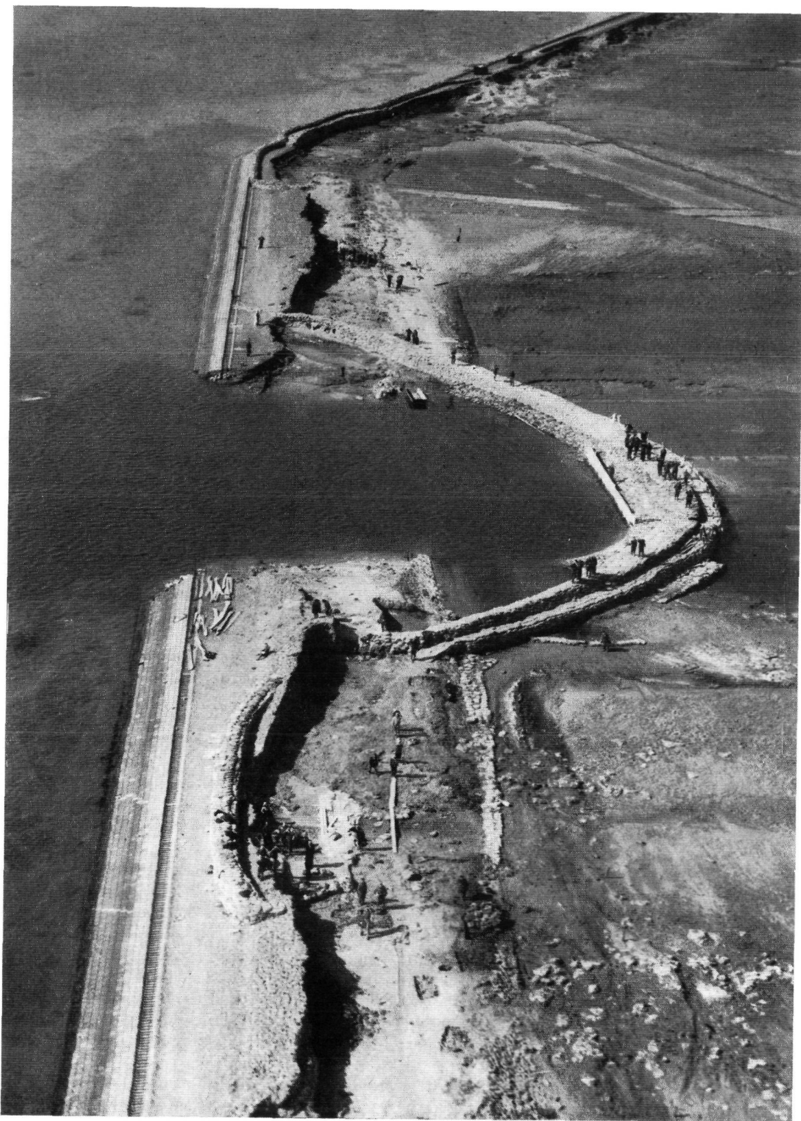
Fig. 4.175. Het gedichte middelste stroomgat in de hoofdwaterkering van de Nieuwe Annex-Stavenissepolder door middel van een inlaagkade van kleizakken, gezien in N.W.-richting
