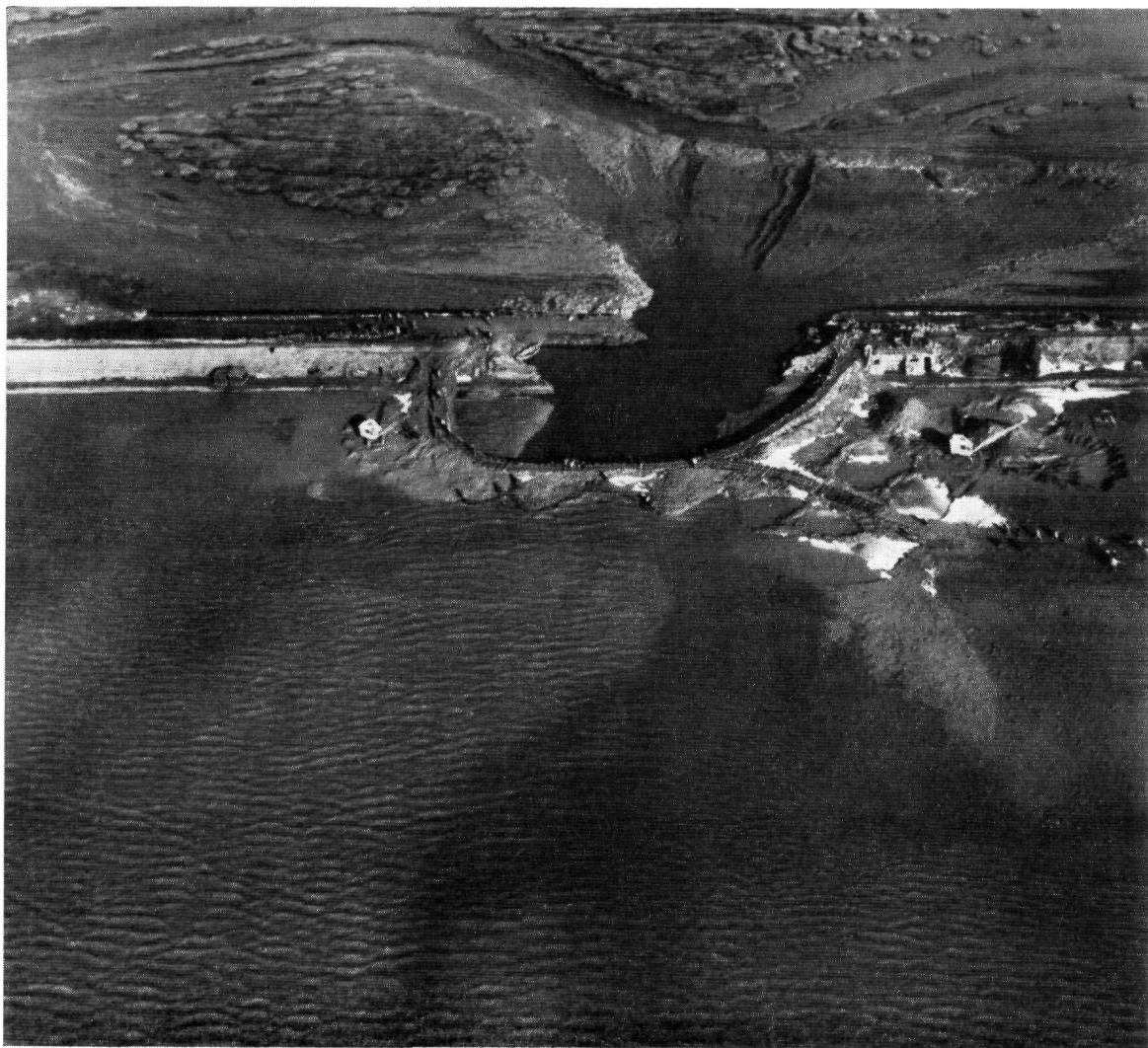
Fig. 4.186. Het gedichte stroomgat in de hoofdwaterkering van de Suzannapolder op Walcheren door een inlaagkade van kleizakken
