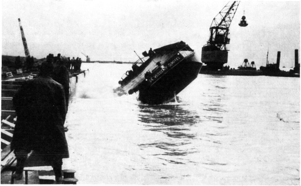
Fig. 4.160. Storten van steen door een kantelbak tegen de zeezijde van het geblokkeerde westgat in de hoofdwaterkering van het Waterschap Kruiningen op 9 mei 1953
