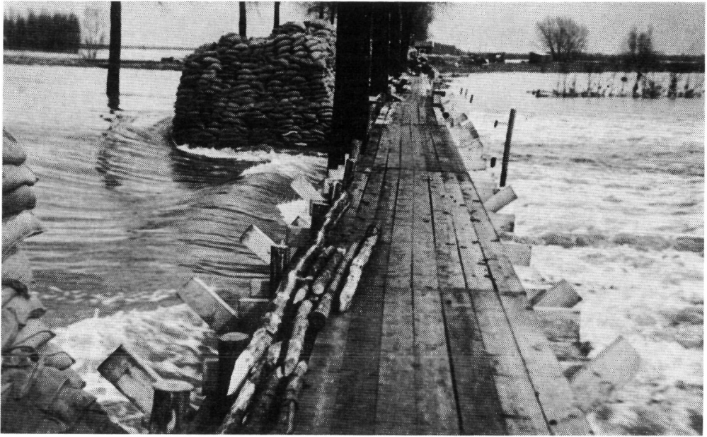
Fig. 4.157. Pijlers van zandzakken met loopsteiger in het sluitgat op de rijksweg ten behoeve van sluiting Kadijk Foto Kruithof
