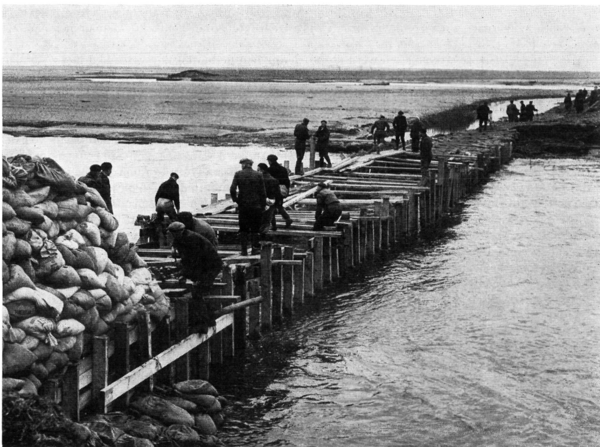
Fig. 4.176. Het dichten van het noordelijke stroomgat in de hoofdwaterkering van de Willempolder op Sint Philipsland door middel van een kistdam met zand- of kleizakkenvulling. Op de achtergrond het zuidelijke stroomgat in de binnendijk. Foto Arbeiderspers
