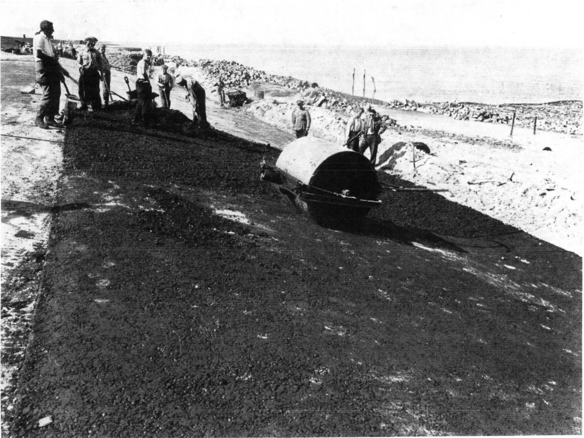
Fig. 4.82. Spreiden van de 10 cm dikke laag asfaltbeton en inwalsel loodrecht op de kruin van de dijk Foto Renes, Arnhem
