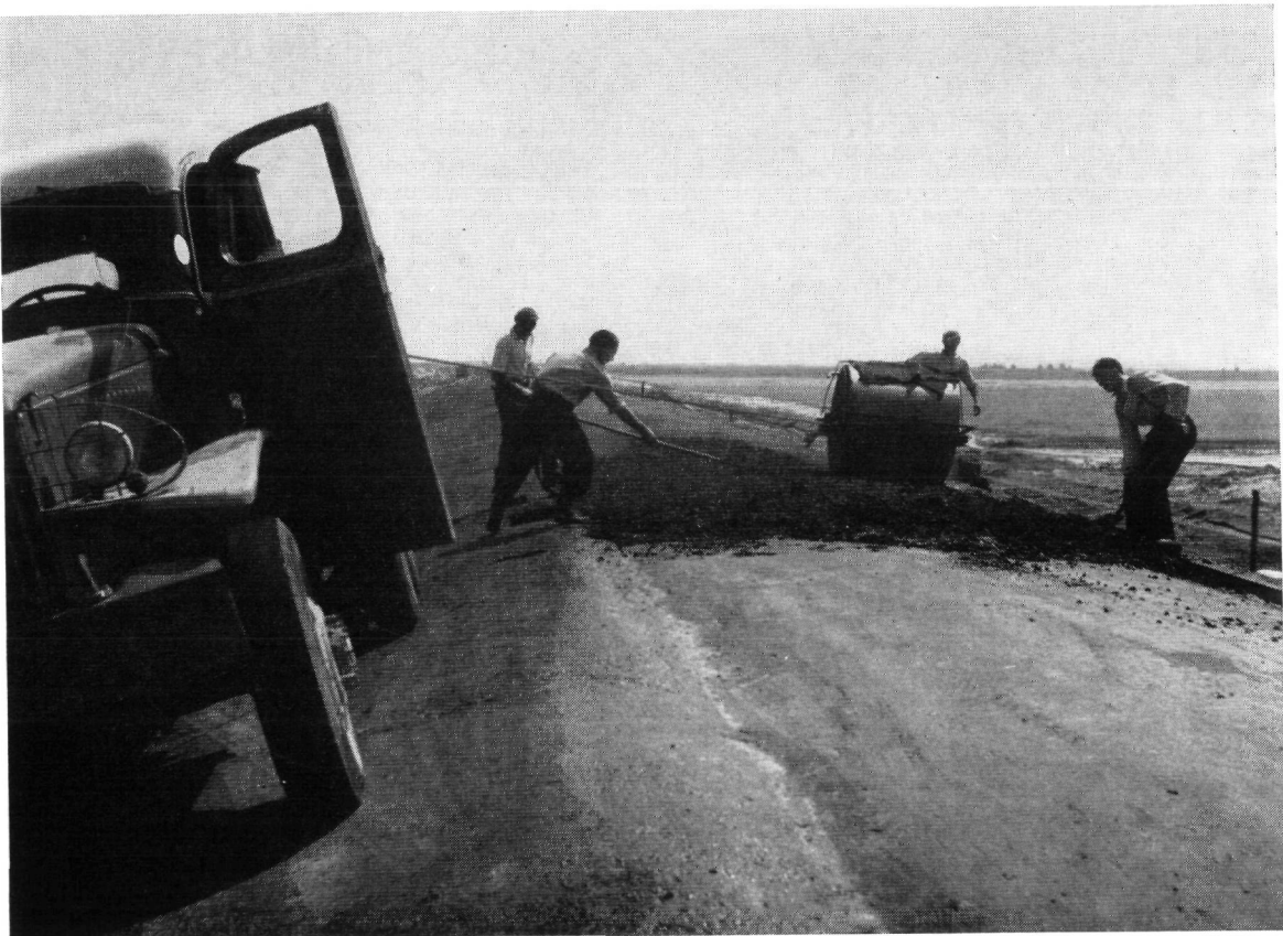
Fig. 4.83. Spreiden van de 10 cm dikke laag asfaltbeton op de kruin en het afwalsen Foto Shell
