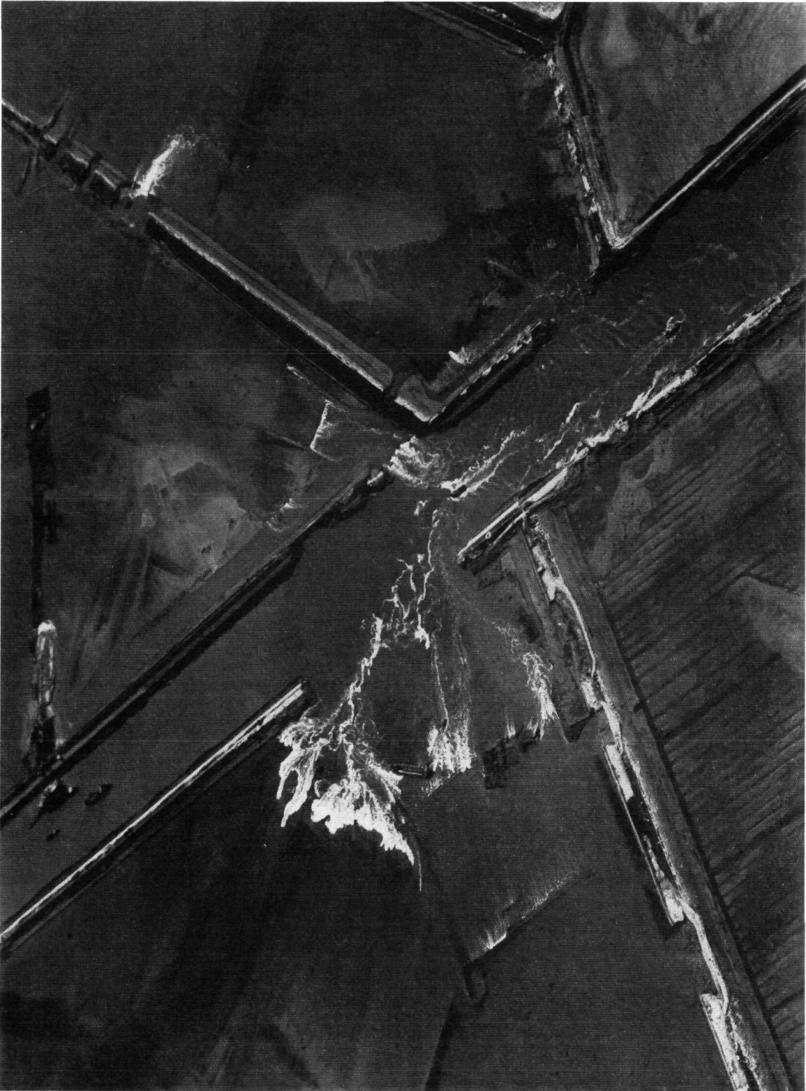
Fig. 4.89. De toestand van de havendammen van Zierikzee op 1 mei 1953. De capaciteit van het stroomgat ten noorden van de gedichte inlaagdijk in de Westelijke havendam is sterk toegenomen. Op de achtergrond de in aanleg zijnde inlaagdijk voor afsluiting van de Polder Zuidhoek van het buitenwater Foto K.L.M.-Aerocarto
