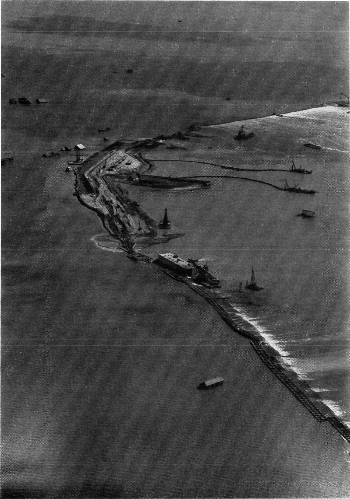
Fig. 4.98. Het Vogeleiland met aansluitende caissondammen van de inlaagdijk bij Schelphoek op 26 augustus 1953. Op de voorgrond de met een Phoenixcaisson geblokkeerde Gemene Geul en gebruikte zinkschepen. Bij eb stroomt het water uit de polder over de caissondam en door talloze lekken er onder door.
