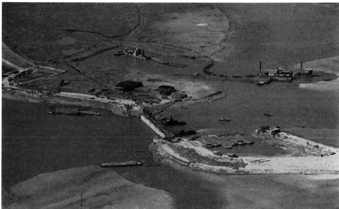
Fig. 4.107. Het blokkeren van het stroomgat bij Stevensluis in de zeedijk van de Polder Vierbannen van Duiveland met een eenheidscaisson met guillotine op 28 juli 1953. Op de achtergrond rechts de gebaggerde werkhaven en de zuiger „M.C. Vaarwater”. Foto K.L.M.-Aerocarto
