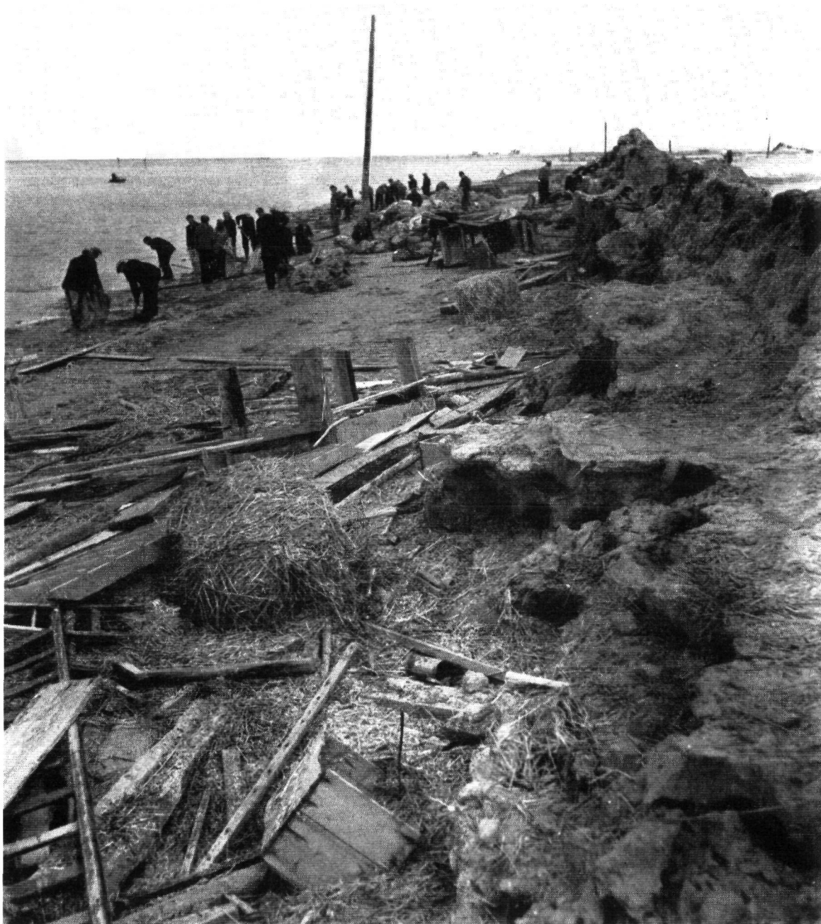
Fig. 4.113. De toestand van de door golfslag en getij zwaar beschadigde Rampaartse Dijk op 23 april 1953
