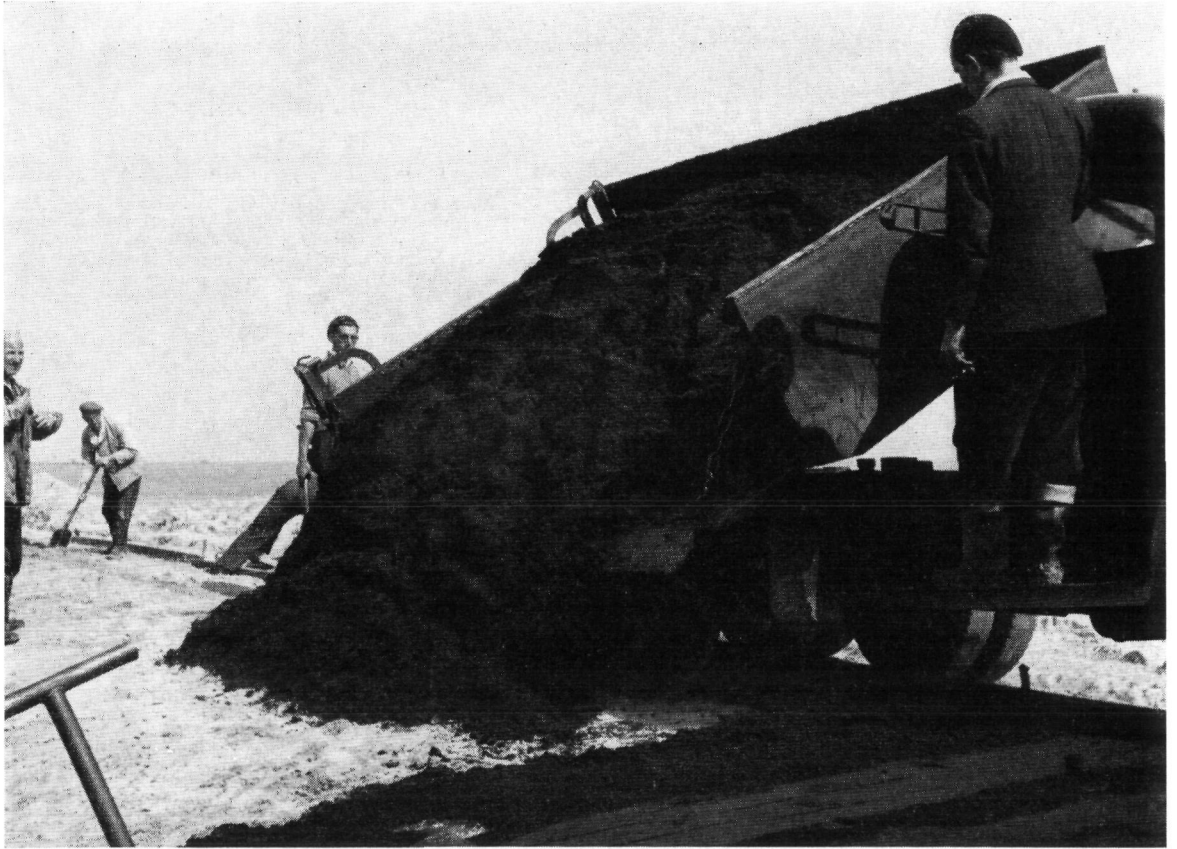
Fig. 4.84. Aanvoer van zandasfalt per kipwagen op de kruin van de dijk
