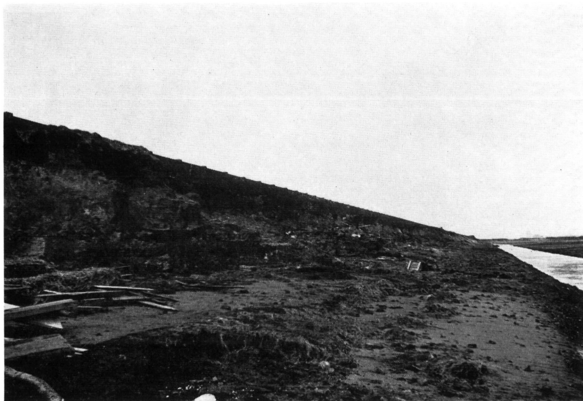
Fig. 3.9. Dijk van de polder Vierbannen van Duiveland, tussen Noordbout en Zuidbout. Binnentalud bijna geheel verdwenen; dijkmurtjes ongeschonden op hun plaats.
