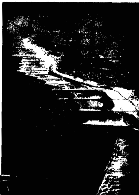
Fig. 6. De duinverdediging te Zoutelande. Door de eeuwenlange achteruitgang van de aangrenzende kust is een uitstekend bolwerk ontstaan. Foto: KLM-Aerocarto (1954)
